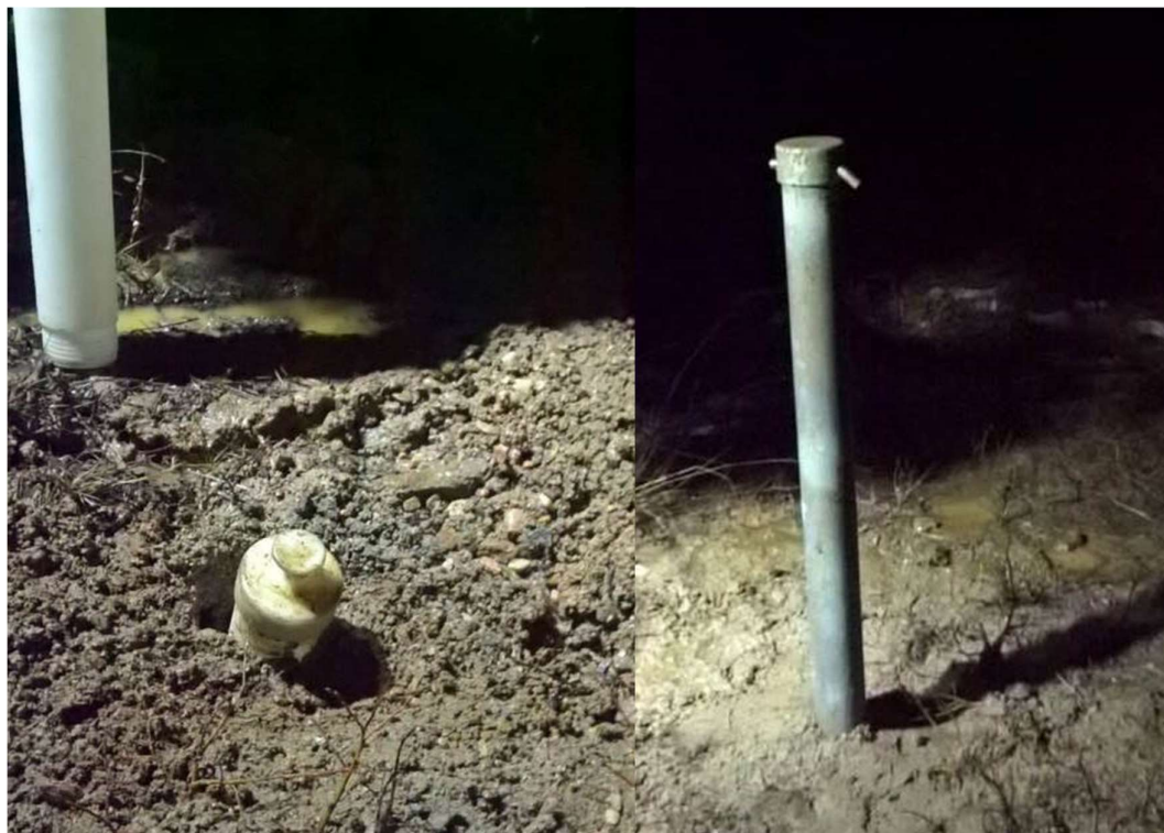
Kuva 24a. Maahan painetun pohjavesiputken pää. Kuvan vasemmassa yläkulmassa on samanlaista viemäriputkea, jota on käytetty pohjavesiputken umpinaiseen osaan. 24b. Metrin mittainen teräsputki, joka suojaa pohjavesiputkea, ja jonka kautta pohjavedenpinta mitataan.
