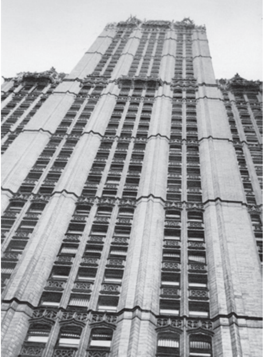
Woolworthin tavaratalon julkisivu. Erich Mendelsohn: Amerika. Bilderbuch eines Architekten 1926.
