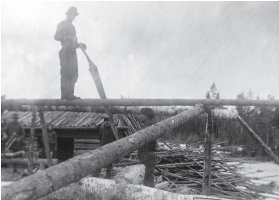
Kuva 6. Lankkujen sahausta Laviassa Keskimäen talon luona. Kuvassa näkyy ylä- ja alasahuri. Yläsahurin tarkoituksena oli pitää huoli siitä, saha kulki suoraan. Kuva nro 49343, Satakunnan Museon kuvakokoelma.
