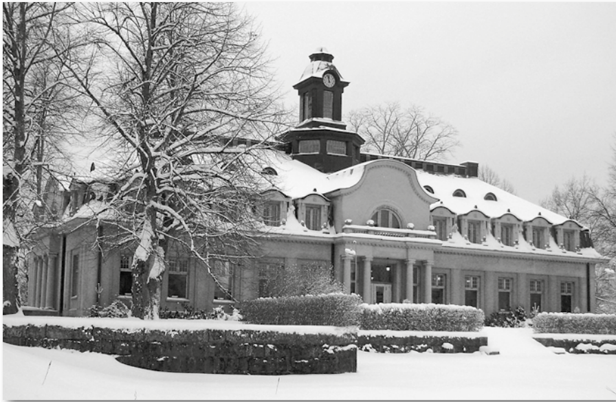
Vuonna 1916 valmistunut pääkonttorirakennus on edelleen hallinnollisessa käytössä. Rakennuksen kellarikerroksessa sijaitsee yhtiön keskusarkisto. Kuva: Maarit Grahn 2012.
