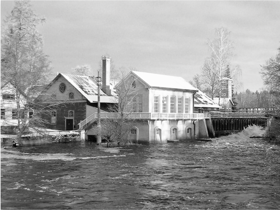
Noormarkun ruukin voimalaitoksen tekniikka peruskorjattiin ja voimalarakennus entisöitiin vuonna 2004. Taustalla vuonna 1894 valmistunut pajarakenus, jossa sijaitsee Ahlström Voyage -näyttely. Kuva: Maarit Grahn 2008.
