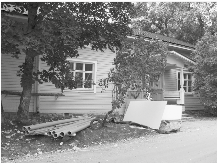
Entisen metsäkonttorin eli Sahalan saneerausvaihe syksyllä 2009. Julkisivultaan suojeltu rakennus koki sisältä miltei täydellisen muutoksen. Kuva: Maarit Grahn 2009.
