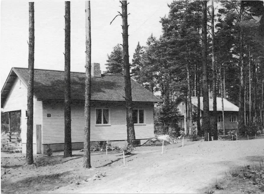
Noormarkun Kirkkosuon asuntoalueen näyttelytalot vuonna 1946. Kuvan oikeassa reunassa näkyy hirsinen ja väritykseltään kahdesta muusta talosta poikennut Talo 1. Kirkkosuon alueen talot ovat edelleen asuinkäytössä ja helposti A-taloiksi tunnistettavissa, vaikka niihin on vuosikymmenien aikana tehty muutoksia. Kuva: Maire-a-säätiön kuva-arkisto.
