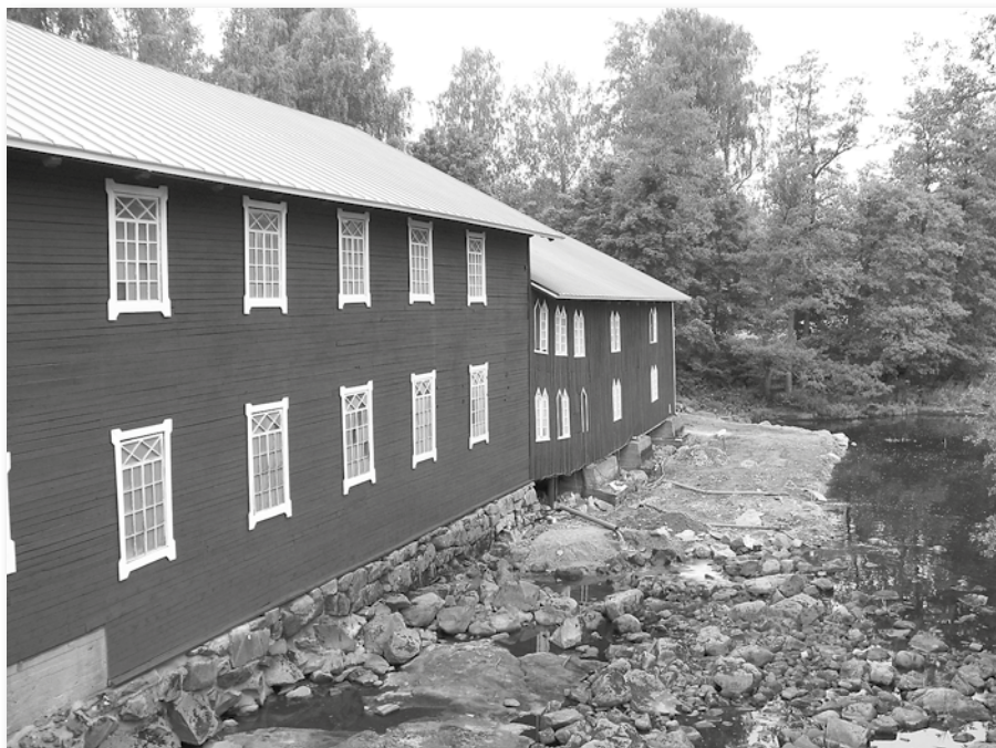
Yhtiö on pitänyt huolta Noormarkun ruukin vanhasta rakennuskannasta. Makkarakosken sahan perustukset ja julkisivu kunnostettiin kesällä 2009. Korjaus toteutettiin osaksi Museoviraston avustuksen turvin. Kuva: Maarit Grahm 2009.
