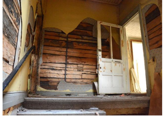
Kuva 2: Vanhat jyrkät hirret ovat rappiosta huolimatta yhä hyvässä kunnossa. Kuvaaja: Terhi Arell 2018.
