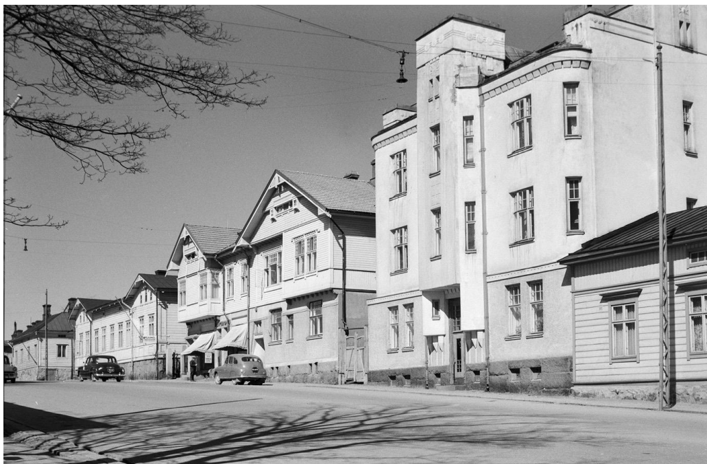
Kuva 9: Kaskenkatu 12–14. Näkymä empiretaloa vastapäätä, Kaskenkadun toisella puolella. Kuva: C.J. Gardberg/Turun museokeskus 1958.
