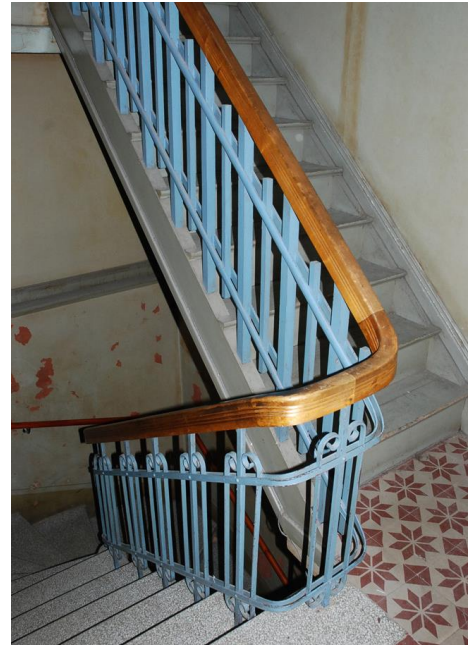
Kuva 2: Rappukäytävän kaiteet, jotka toiseen kerrokseen asti on tehty rautaudasta, ja vinttiin vievät kaiteet puusta. Kuvaaja: Terhi Arell 2009.
