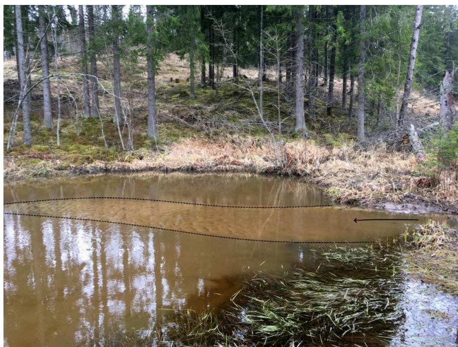
Kuva 67. Imponojan laskeutusaltaan tulo-uoman suulla keväällä 2018 kuvattua kiintoainekasaumaa (rajattu katkoviivalla) ei ollut vielä vuonna 2017. Nuoli kuvaa tulo-uoman virtausta altaaseen. Kuva: Santtu Kaipainen.
