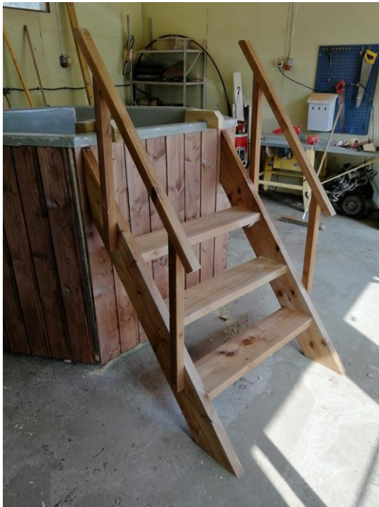
Kuva 19. Ulkoportaajat ja panelointi.
