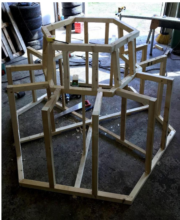
Kuva 3. Muotin puurunko miltei valmiina.
