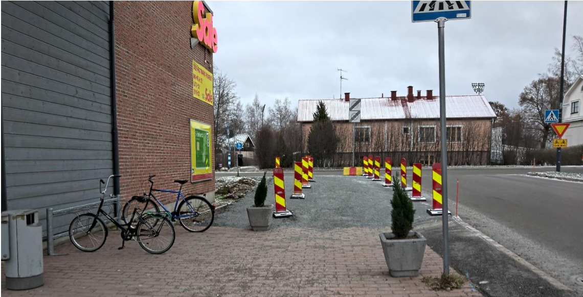
Kuva 29. Oikopolku A:n entinen paikka rakennustöiden jälkeen 11.12.2019.
