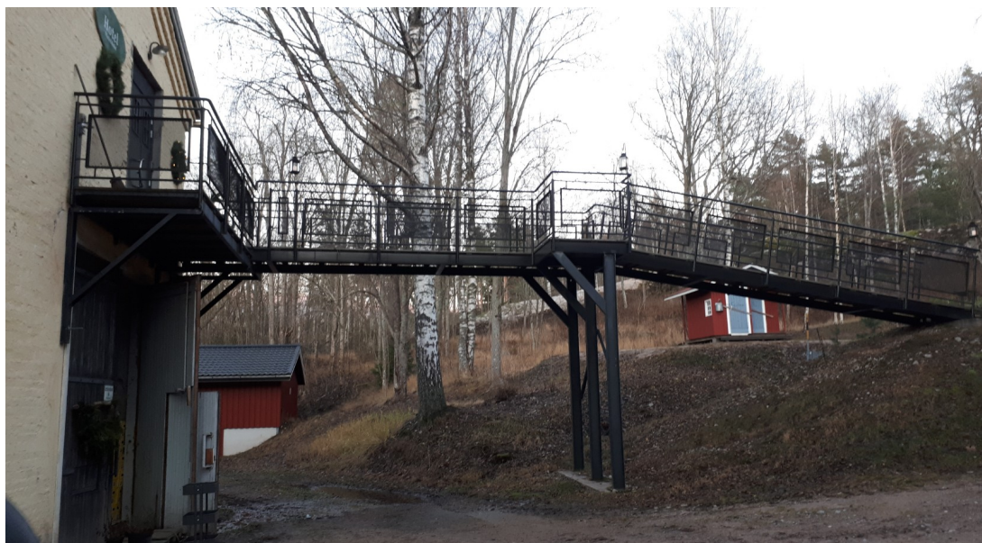
Kuva 2: Kulku Mathildedalin hotelliin. Kulku hotellihuoneisiin jouduttiin rakentamaan kokonaan uudelleen ja uusien sovittamista jouduttiin hiomaan julkisivun arvon säilymisen vuoksi. Kuvaaja Birgit Aittakumpu 28.11.2020.
