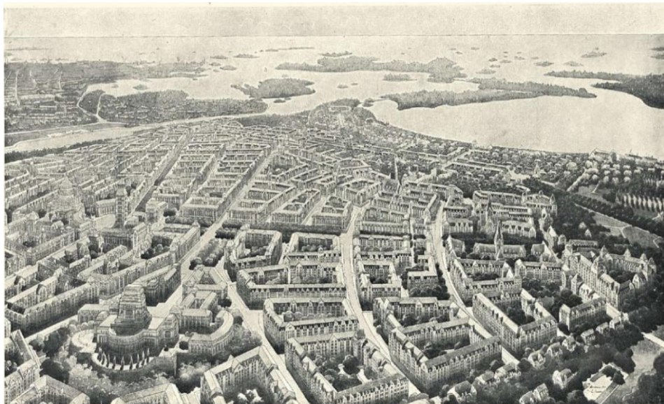
Kuva 8: ”Munkkiniemi pohjoisesta katsottuna, meri taustana”. Perspektiivipiirustus. Saarinen, Eliel: Munkkiniemi-Haaga ja Suur-Helsinki . Saarinen 1915, [155].
