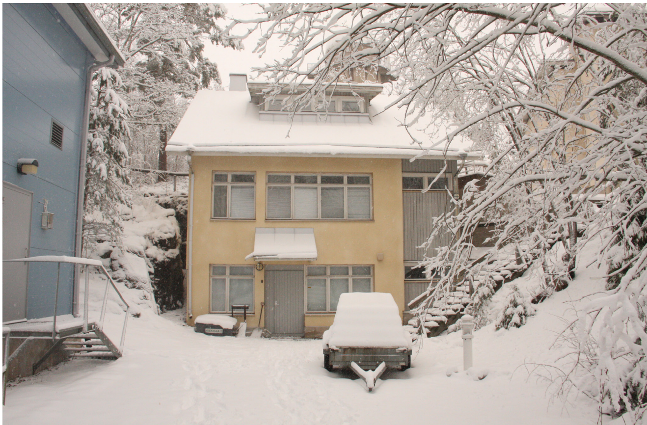
Kuva 1: Tunnelin eteläpäädyn ulkorakennus, julkisivu kuvattuna suoraan etelästä. Arkistoitu tunnuksella MUSE-dg-3710.
