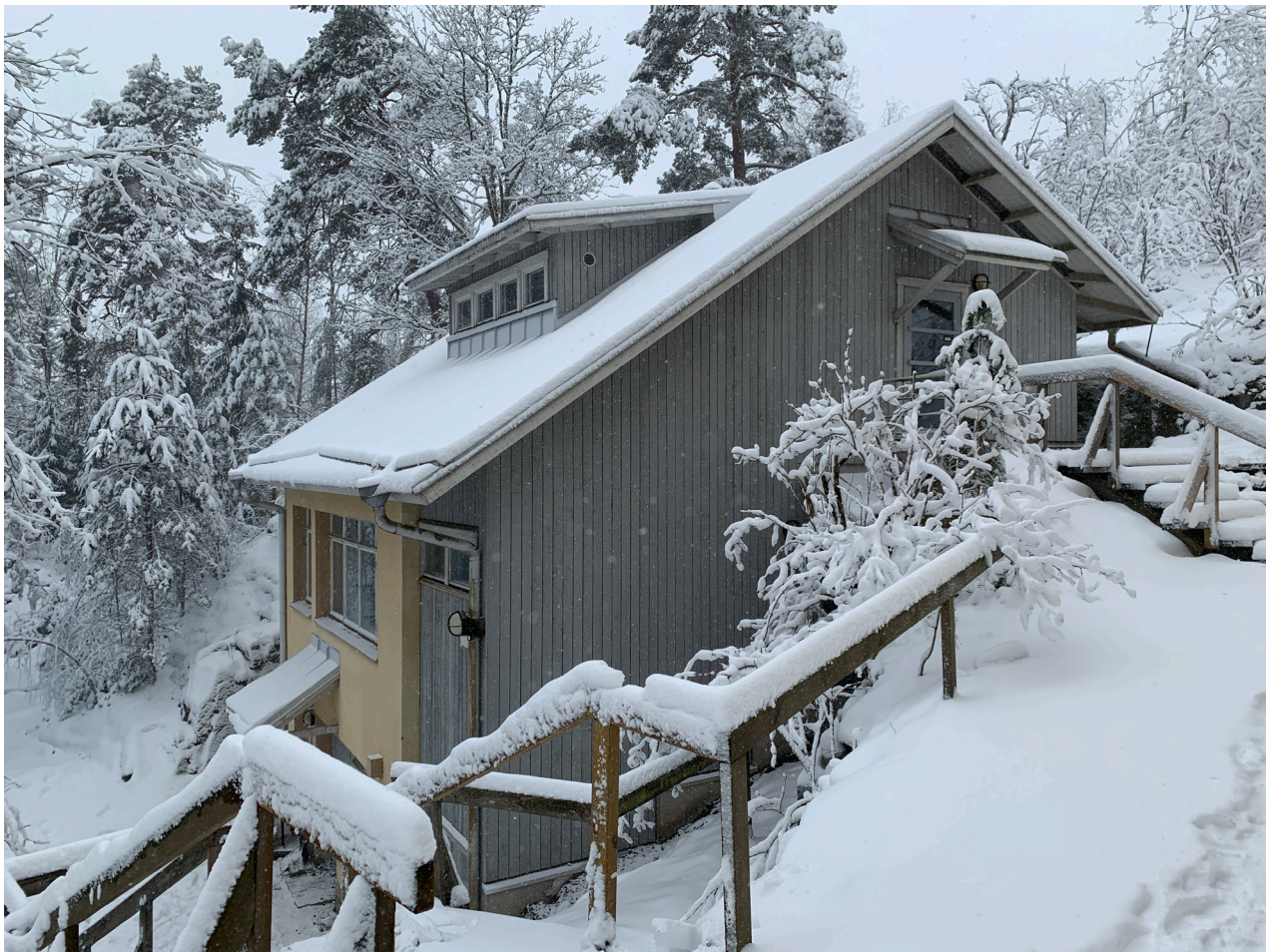
Kuva 3: Tunnelin eteläpäädyn ulkorakennus ja portaat kuvattuna viistosti portaiden yläpäästä. Arkistoitu tunnuksella MUSE-dg-3713.
