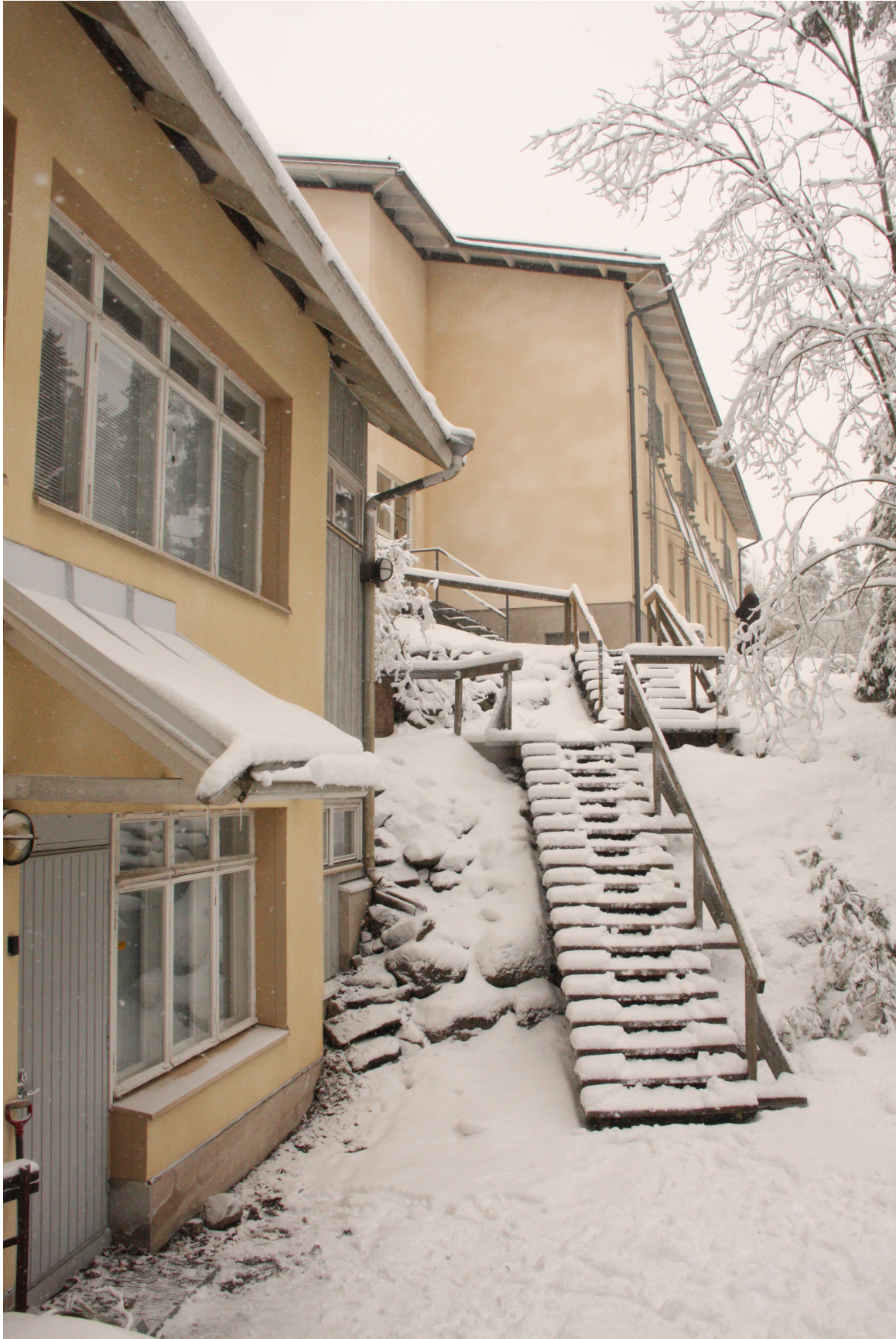
Kuva 2: Tunnelin eteläpään ulkorakennus, julkisivu ja portaat kuvattuna viistosti. Arkistoitu tunnuksella MUSE-dg-3712.
