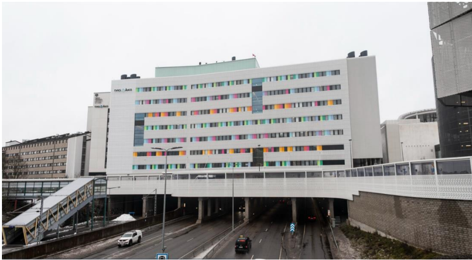
Kuva 1. Varsinais-Suomen sairaanhoitopiirin T3 sairaala kannella rata- ja tieväylän päällä (Kuva: Tatu Lertola, Rakennuslehti 9.12.2023.)
