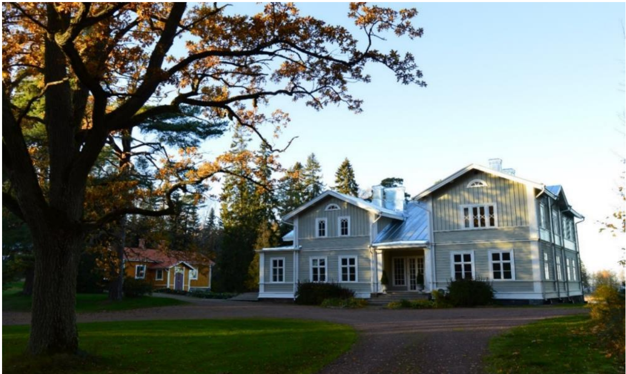
Kuva 15. Grankulla huvila kuvattuna lokakuun lopussa 2023 ruska-aikaan. Huvilan saumapeltikatto loistaa uutuuttaan. Pihapiirin entinen talonmiehen asunto on samoin kunnostettu ja maalattu. Valokuva Anne Salonen, lokakuu 2023.
