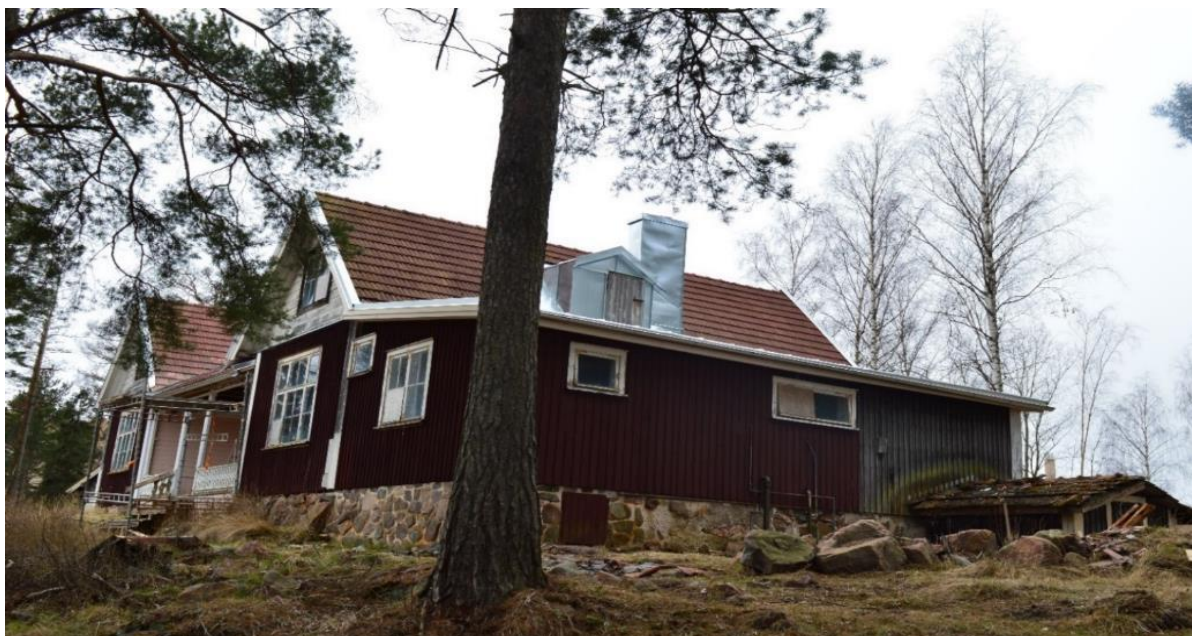
Kuva 13. Rauhanlinnan merenpuoleinen pääty, jossa näkyvissä keväällä aloitettu pellitystyö. Valokuva Anne Salonen 2024.
