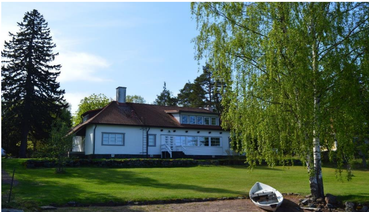
Kuva 24. Olhava rannan puolelta kuvattuna. Huvilan julkisivulle antavat ilmettä suuret ikkunarivit meren suuntaan, jotka avaavat näkymän huvilasta vesistöön. Valokuva Anne Salonen, kesäkuu 2023.
