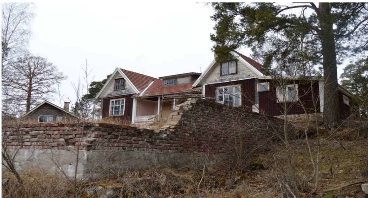
Kuva 12. Rauhanlinna kuvattuna edessä avautuvaan Majasaarta ympäröivään lahteen. Vanhan tiilimuurin takaa pilkottaa uusi Rauhalinna savupiippuneen. Huvilan otsalaudat ja sinkityt vesikorut hohtavat uutuuttaan. Valokuva Anne Salonen 2024
