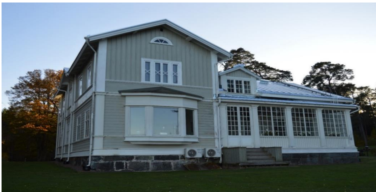
Kuva 17. Grankulla meren suunnasta kuvattuna. Lasiveranta on aikoinaan ollut avoveranta, jossa ovat olleet markiisit suojana. Nykyajasta kielivät ilmalämpöpumput, jotka ovat sijoitetut entiselle pääsisäänkäynnin puolelle. Valokuva Anne Salonen.
