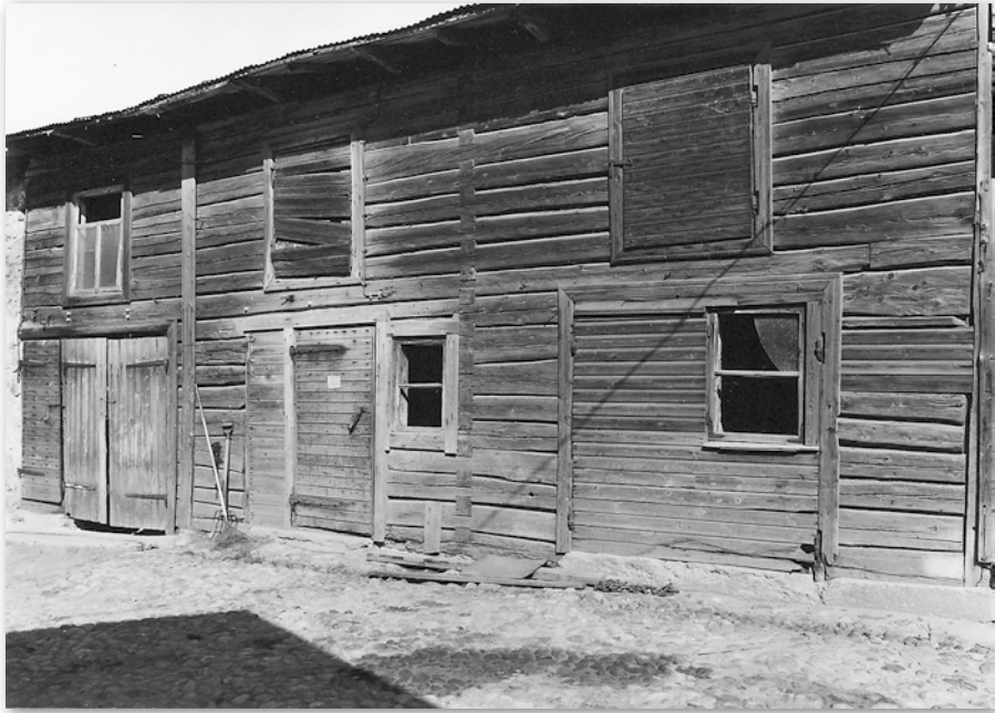
Niemen piharivin puinen, vuonna 1896 rakennettu osa purettiin vuonna 1984 ja tilalle rakennettiin katos. Rakennuksessa on ollut hevostalli. Vasemmanpuoleisessa päädyssä ikkunan kohdalla on ollut käymälä rakennuksen toisessa kerroksessa. Käymälän alla oli ruuma. Kuva: Voitto Niemelä 1969, Satakunnan Museon arkisto, Pori.
