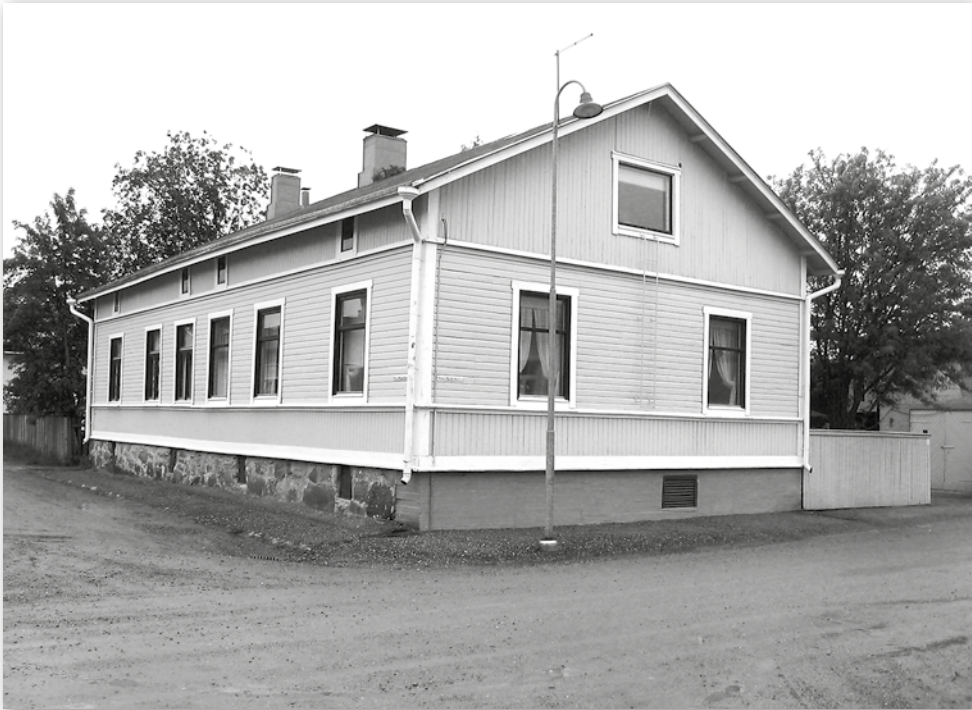
Raatimiehenkatu 43, asuinrakennus vuonna 1969 ja vuonna 2008. Yksi piipuista on poistettu, päädyn perustus on betonoitu ja ikkunat vaihdettu kaksiruutuisiin. Rakennus on oman aikansa tyypillinen hirsinen kaupunkipuutalo, jossa on luonnonkiviperustus. Kuudesosalaiseksi taloksi se on kuitenkin tavallista isokokoisempi. Kuvat: Voitto Niemelä ja Sari Takala, Satakunnan Museon kuvakokoelma.
