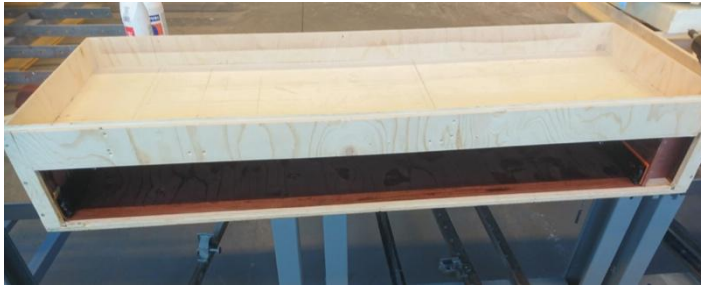
Kuva 59. Alaosa välipohjineen liimattuna kokoon.
