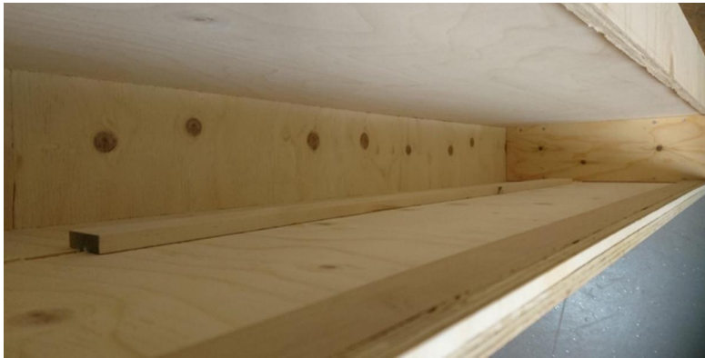
Kuva 31. Vetolaatikkaa varten jyrstetty aukko sekä pohjan jäykistäjät.
