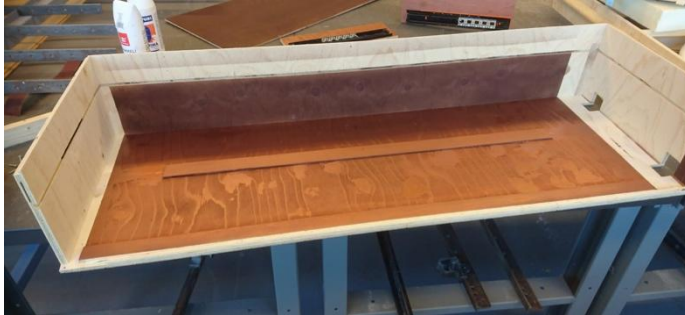
Kuva 56. Alaosan takaseinän ja päätyjen liimaus.
