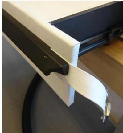
Kuva 82. Vetolaatikon lukitusmekanismi.
