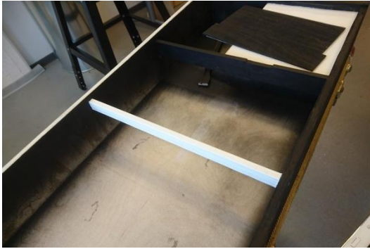
Kuva 70. Väliseinä / jäykistäjä verhoiltuna ja kiinnitettyinä.
