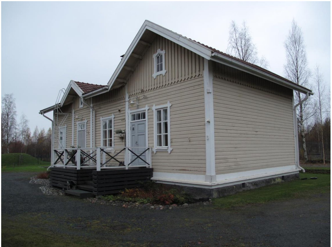
Kuva 7. Nakkilan ratamestarin talo sisäänkäynteineen pihan puolelta.
