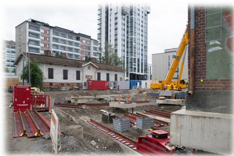
Kuva 13. Tavara-aseman siirto puretun Morkun paikalle. Kuvassa myös puinen rautatieläisten asuintalo. Kuva: Teppo Moilanen / Tampereen museot.
