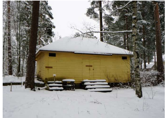
Kuva 19 Aumakattainen ulkorakennus Harjutiellä talvella 2021. Kuva: Liina Luoma.
