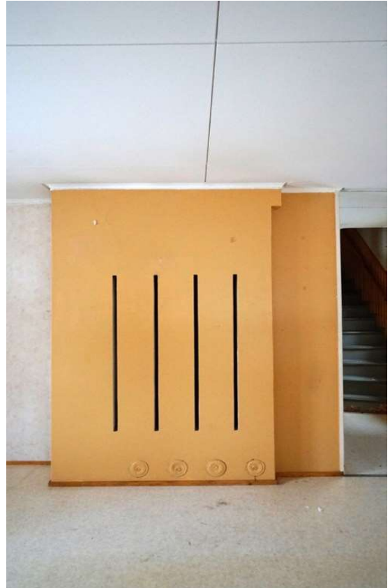
Kuva 34 Alkuperäinen puulämmitysjärjestelmä Harju-tiellä. Puita laitettiin takana olevan keittiön puuhellaan, joka lämmitti muuria ylös asti. Kuva: Liina Luoma
