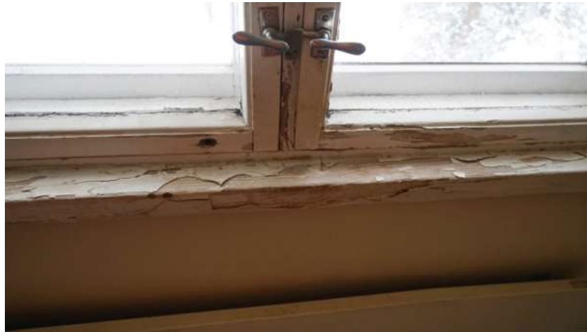
Kuva 35 Nämä Omakotialueen Harjutiellä tyhjiillään olevan tyyppitalon ikkunapuitteet, karmit ja ikkunalauta ovat vielä helposti kunnostettavissa. Kuva: Liina Luoma
