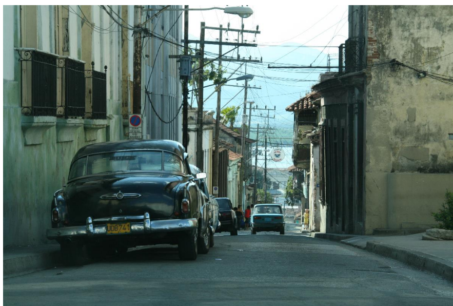
Red eléctrica local, Santiago de Cuba
