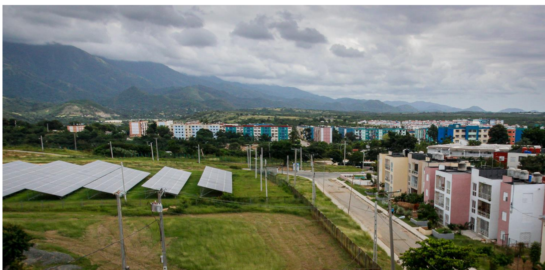
Parque Solar Fotovoltaico, Abel Santamaría, Santiago de Cuba
