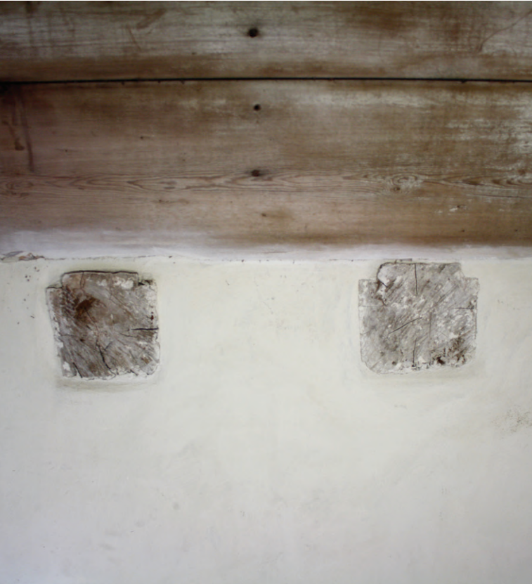
Tiilimuurin reunaan vasten katkaistut alapaarteet näkyvät porrashuoneen seinässä.
