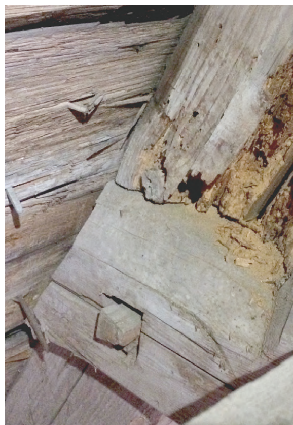
Kattotuolissa tapinreian porausta varten tehty alku on nelikulmainen.
