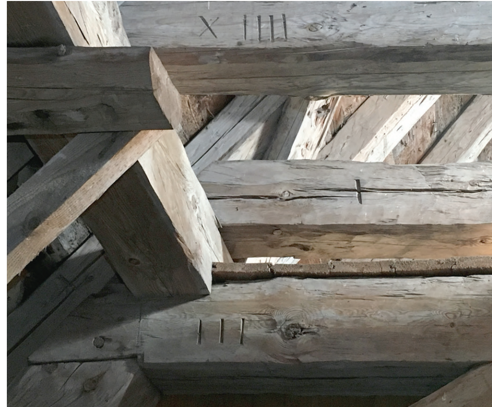
Kattorakenteen liitosmerkkejä.
