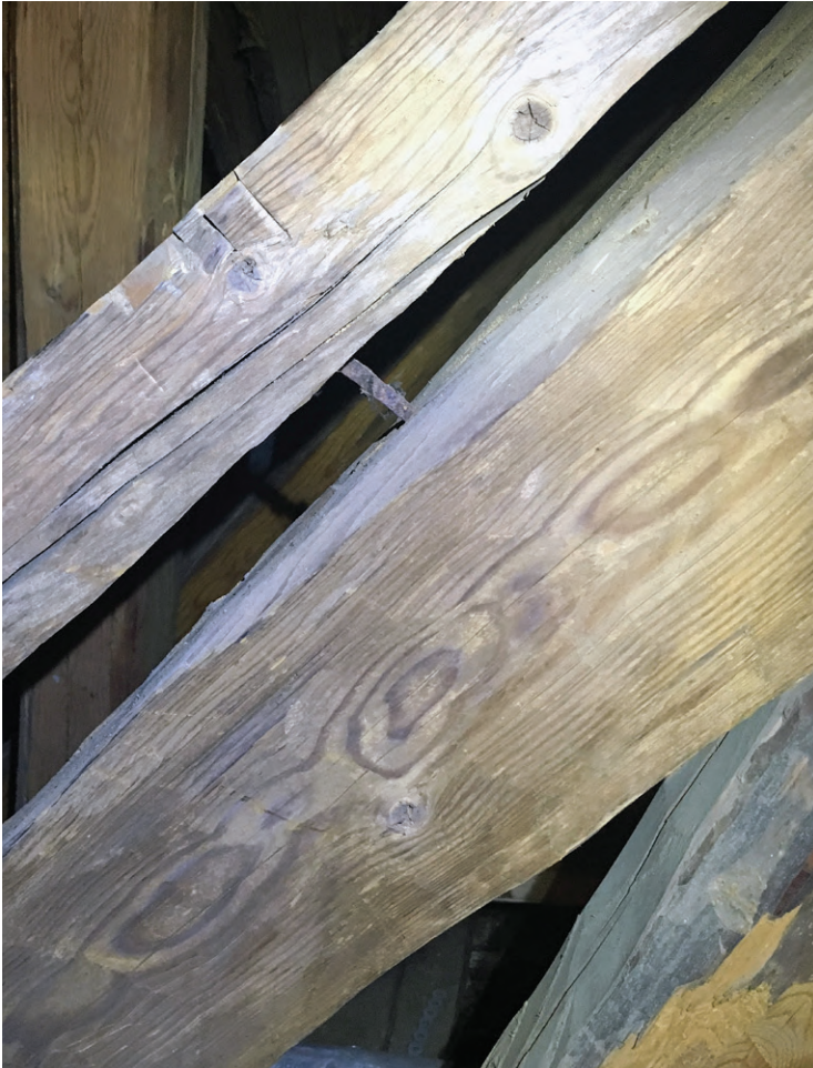
Hollantilainen on kiinnitetty selkäpuuhun naulaamalla.
