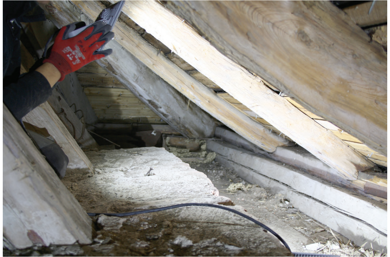
Osa jäleistä kaarevista hollantilaisista on korvattu kapeammalla puutavaralla. Luonnonväärit eli luonnollisesti kaareutuvasta puusta valmistetut hollantilaiset lepäävät massiivisen 7" x 7" räystäähirren päällä loveutuen koururäystääseen.
