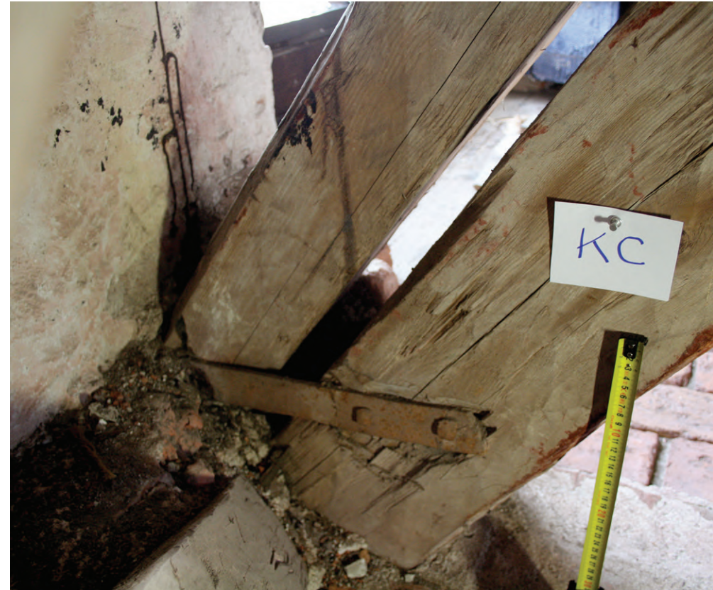
Muurista nousevat kattotuolin selkäpuu ja pukin jalka.
