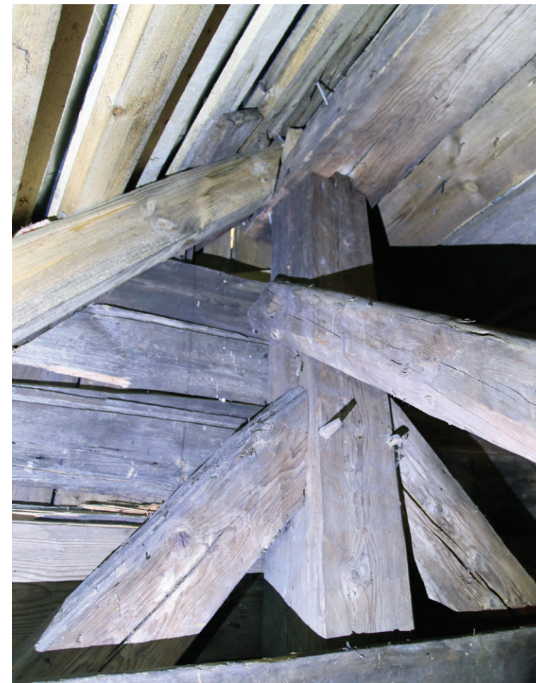
Nyteet on kiinnitetty riipputankoon lovitappiitoksella. Riipputangon ja kurkihirren liitos on myös loviliitos.
