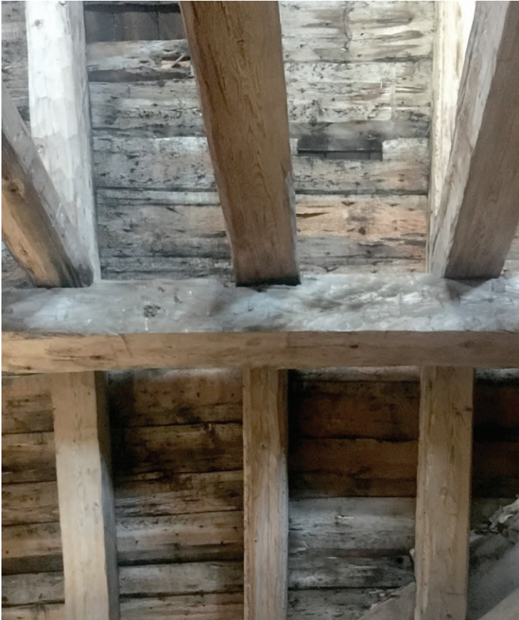
Uloimpia vuoliaisia on tarvittaessa veistetty kitapuiden alta.
