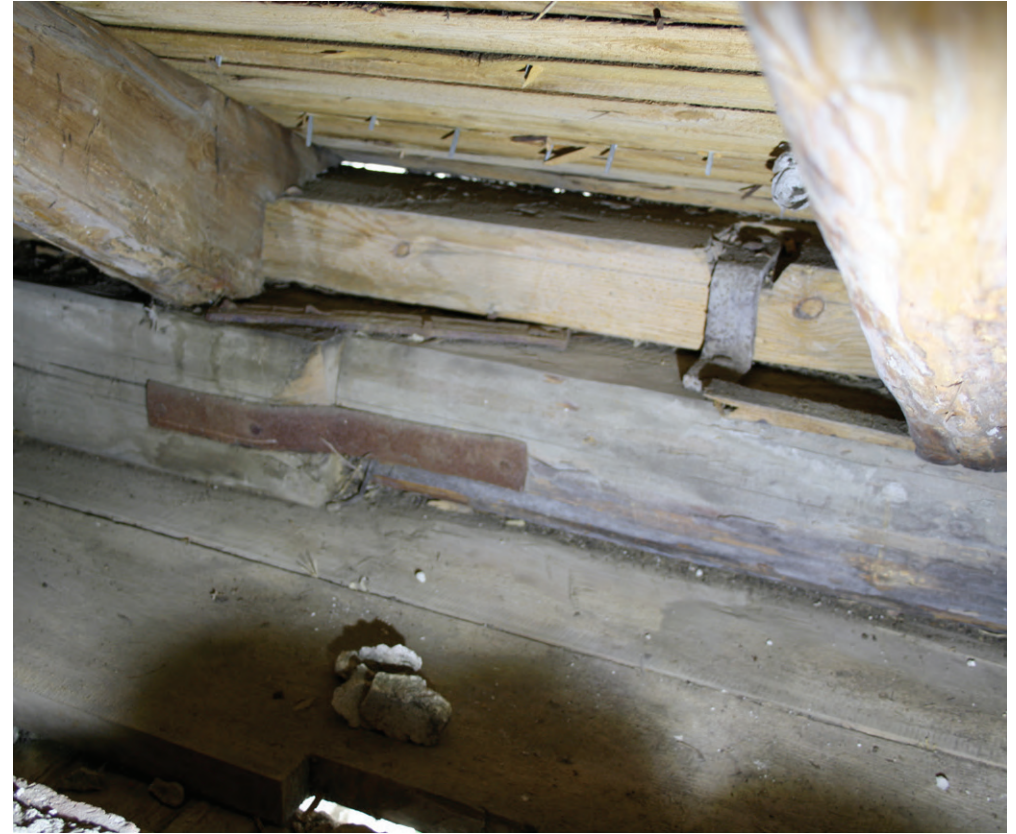
Räystäskonsolin päällä lepäävät räystäslaudat. Räystäshirsiä ja koururäystäspuita on sidottu yhteen metallisin kiinnikkein.
