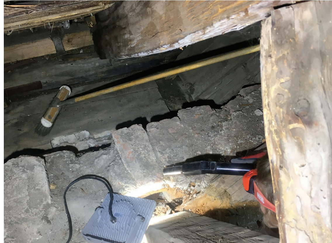
Päädyn rakenneavaus, muuri ja räystäsväljäältä katsottuna.
