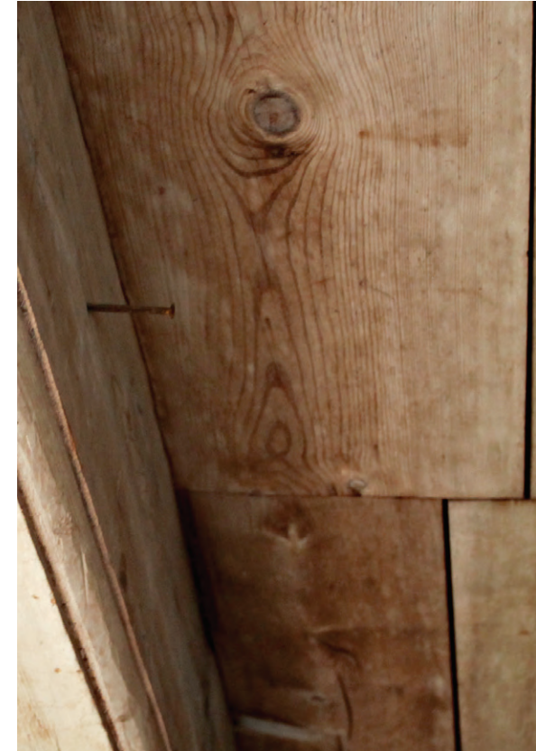
Yläpohjan maalaamatonta laipiolaudoitusta portaan varastossa.
