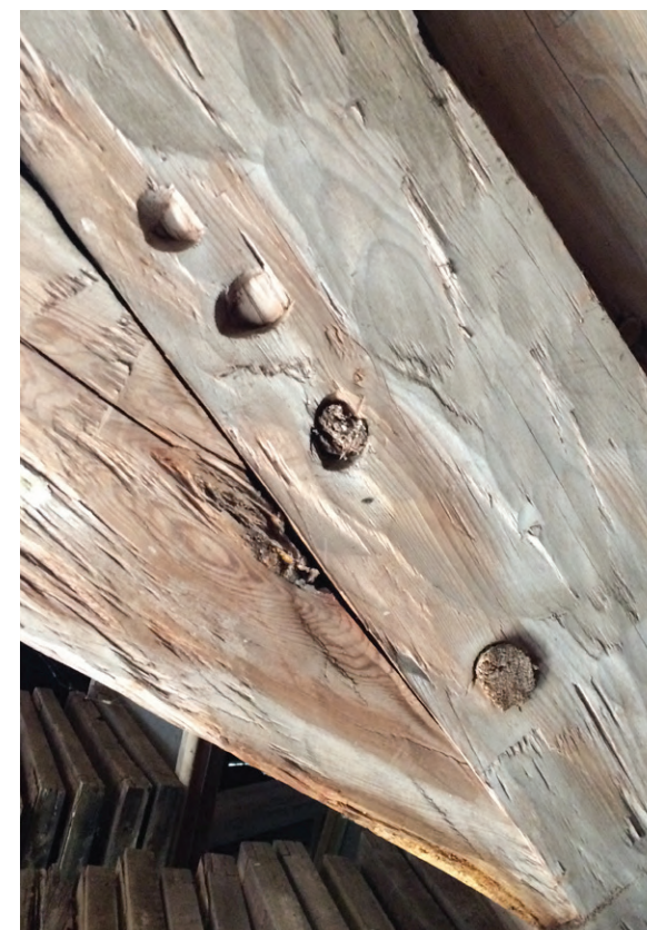
Pukissa porauksen alkukohta on pyöreämpi.
