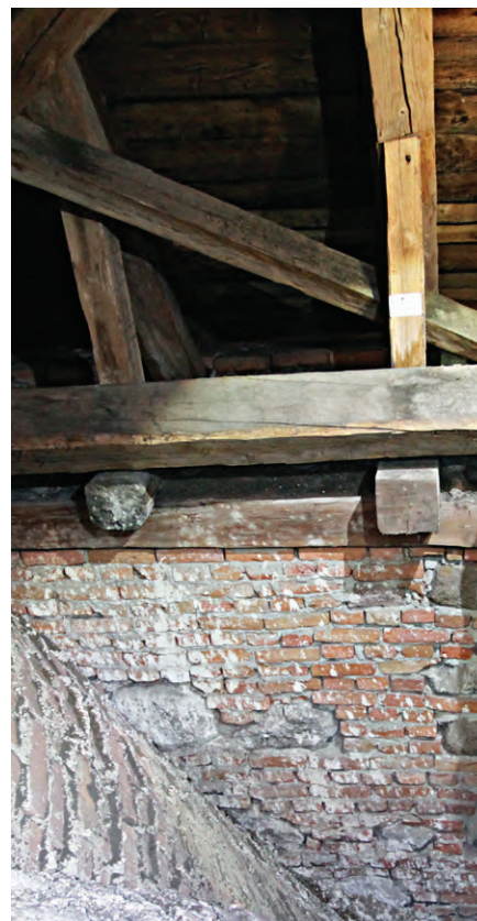
Kattotuolien käpälät lepäävät jalasparrun päällä.
