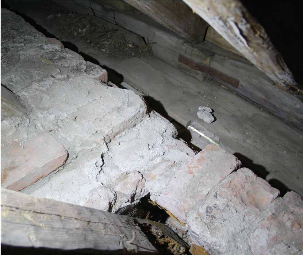
Räystäslautojen raosta näkyy konsolipalkki.
