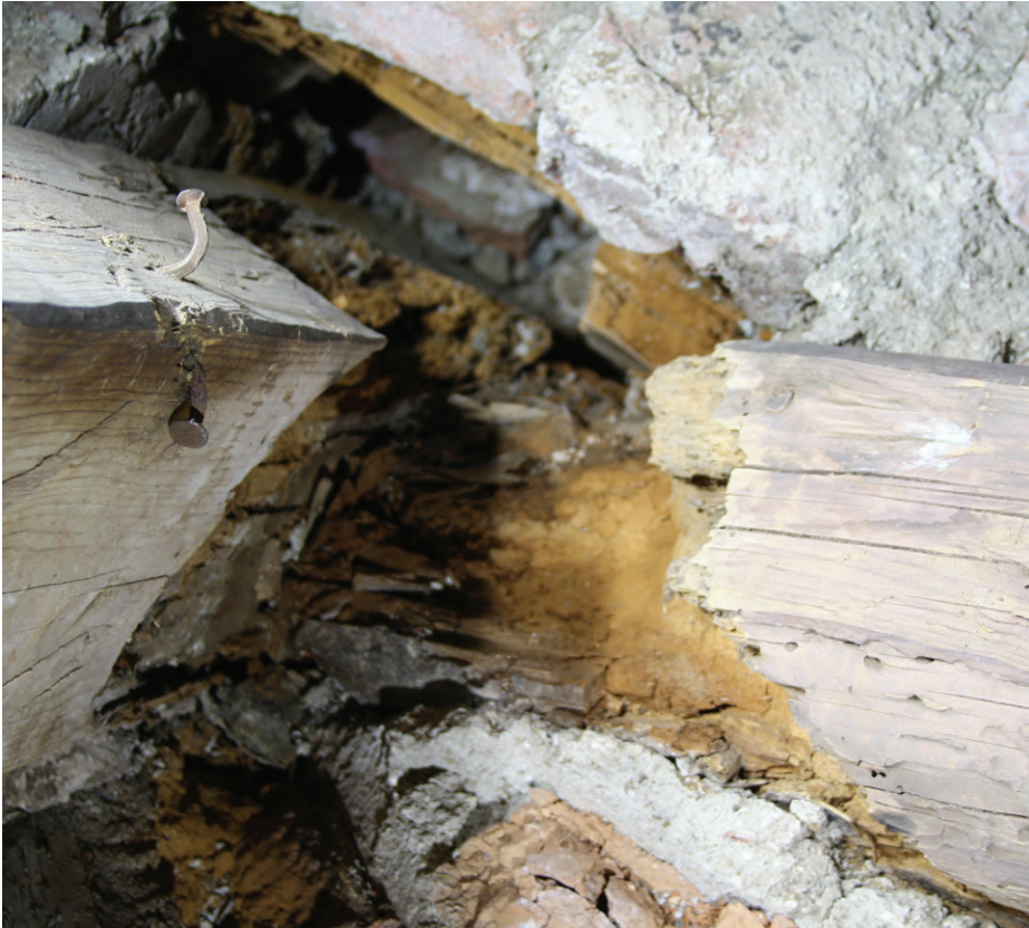
Näkymä päädyn rakenneavaukseen.
