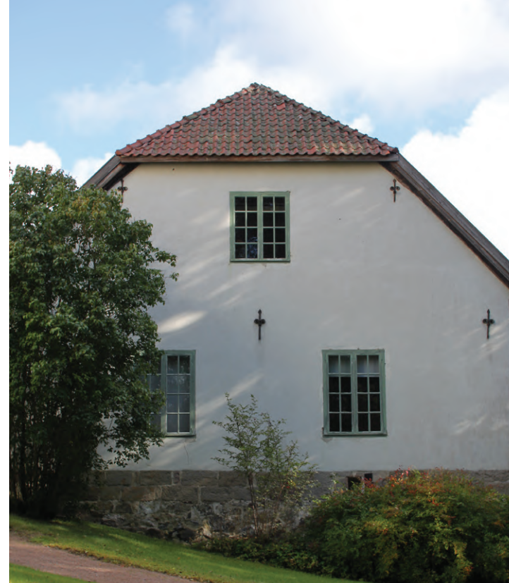
Sivurakennusten kattojen aumat on rakennettu 1700-luvun loppupuolella.
