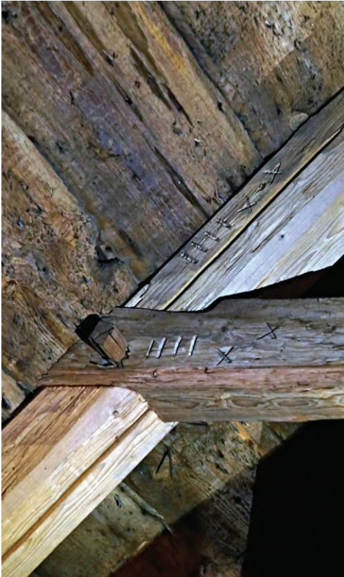
Vesikattorakenteen osat on nimikoitu.
