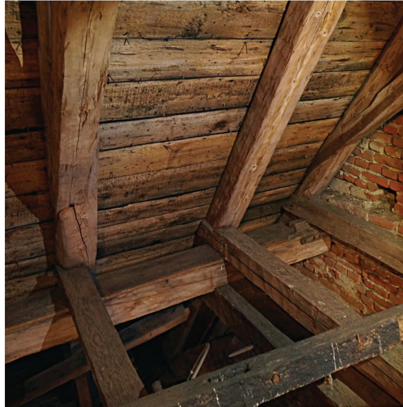
Joka neljännen kattotuolin kohdalla on pukkirakenne. Rakennuksen päissä uloimman pukkirakenteen ulkopuolella on vielä yksi kattotuoli. Uloin kattotuoli on kiinnitetty päätymuuriin ankkuriraudoin.
