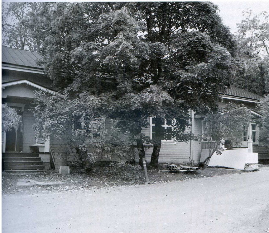
Entisen metsäkonttorin eli Sahalan saneerausvaihe syksyllä 2009. Julkisivultaan suojeltu rakennus koki sisältä miltei täydellisen muutoksen. Kuva: Maarit Grahn.
