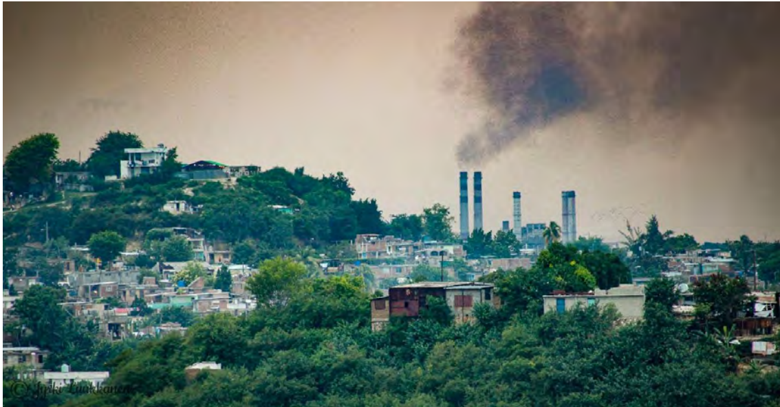
A power plant, Santiago de Cuba (Termoeléctrica)
