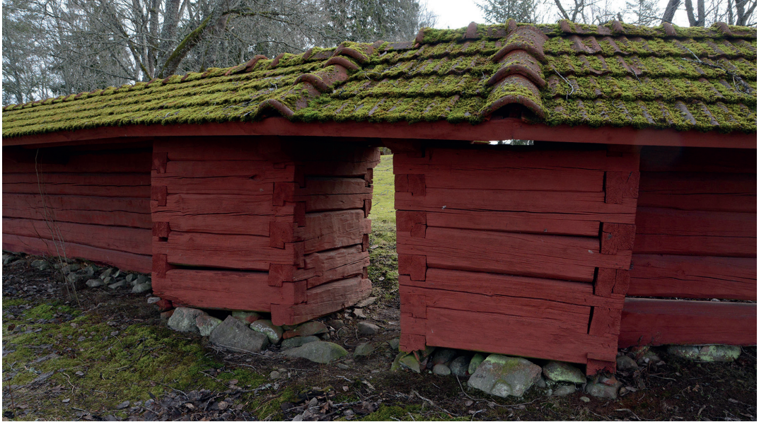
Kuva 18. Pöytyän vanhan kirkkomaan salvosaidassa on kuusi päällekkäin asetettua hirttä ja tiilikate. Aita on rakennettu matalan kiviperustuksen päälle. Kuvassa luoteisosan kapea ja matala sisäänkäynti. Kuva: J. Ruuhonen.
