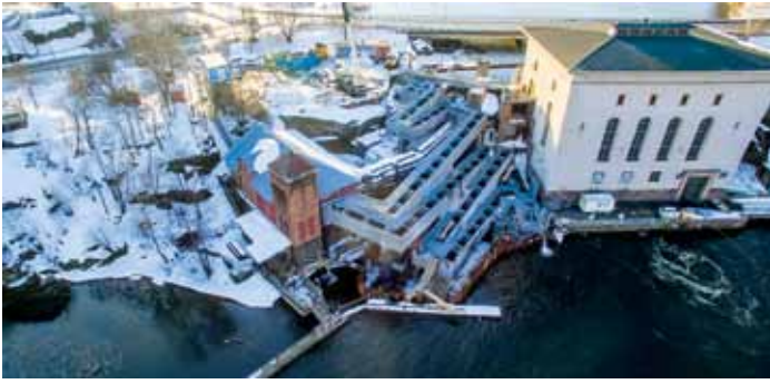
Kymijoen Korkeakosken kalaporras rakenteilla. Kuva: Kaakkois-Suomen ELY-keskus
