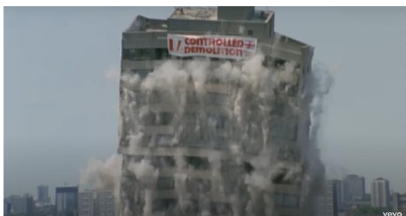
Kuva 4. Viittaus gentrifikaatioon ( WFL :n kohdassa 02.43).
