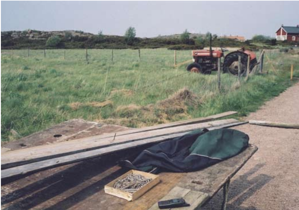
Kuva 10. Lounastauko lammasha'an aitatyömaalla Jurmossa. Valok. Katriina Siivonen 2001.
