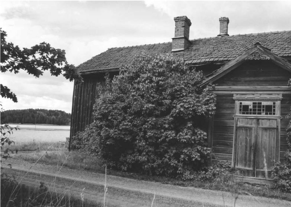
Kuva 3. Autioitumisen merkkejä sisäsaaristosta Piikkiön Harvaluodosta. Valok. Katriina Siivonen 1999.
