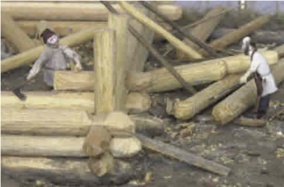
Kuva 2.11: Hirsisalvosrakennuksen pystytystä (Museo- ja kulttuurikeskus Harkko / pienoismalli Kaj Puumalainen / Valok. V-M Väärä) Fig. 2.11: Building a corner jointed timber house
