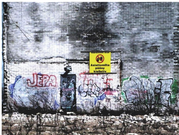
Kuva 21. ”Vaarallinen alue – Asiattomilta pääsy kielletty”, rehutehtaan raunioilla (S. P. 2010).
