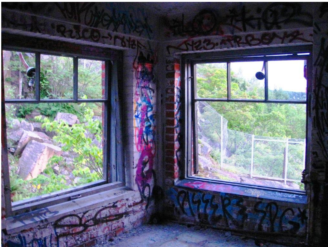
Kuva 24. Wärsilän konehuone oli täynnä ihmisten jättämiä jälkiä (S. P. 2011).
