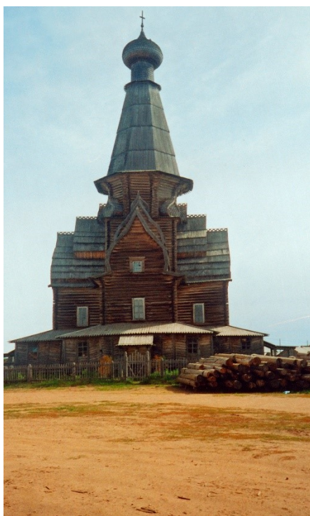
Kuva 51. Länsirannalla oleva Uspenskin kirkko v. 2003, odottaa korjausta.
