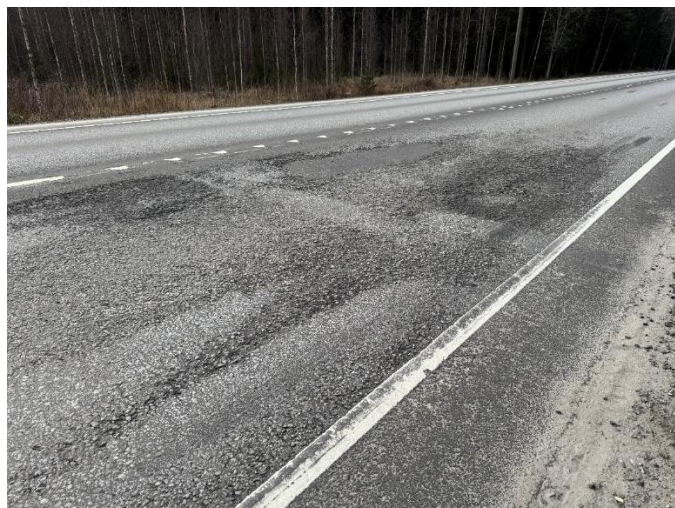
Kuva 10. 2025 VAR ELY -urakkaan kuulunut kohde, sama kohta, kuin kuvassa 9. Kuva: Kasper Lehtinen, 12.4.2026.
