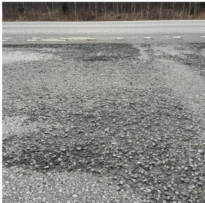
Kuva 9. 2025 VAR ELY -urakkaan kuulunut kohde. Päällystetty 15.10.2025. Kuva: Kasper Lehtinen, 12.4.2026.
