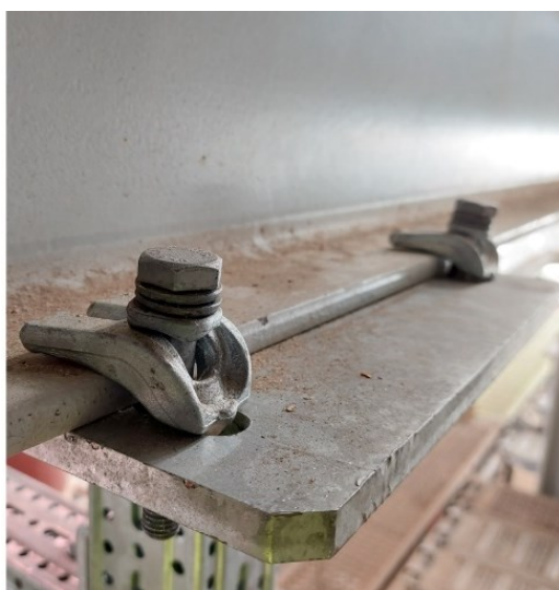
Kuva 15. Modulaarisen sekundäärikannakkeen tartunta I-palkkiin.
