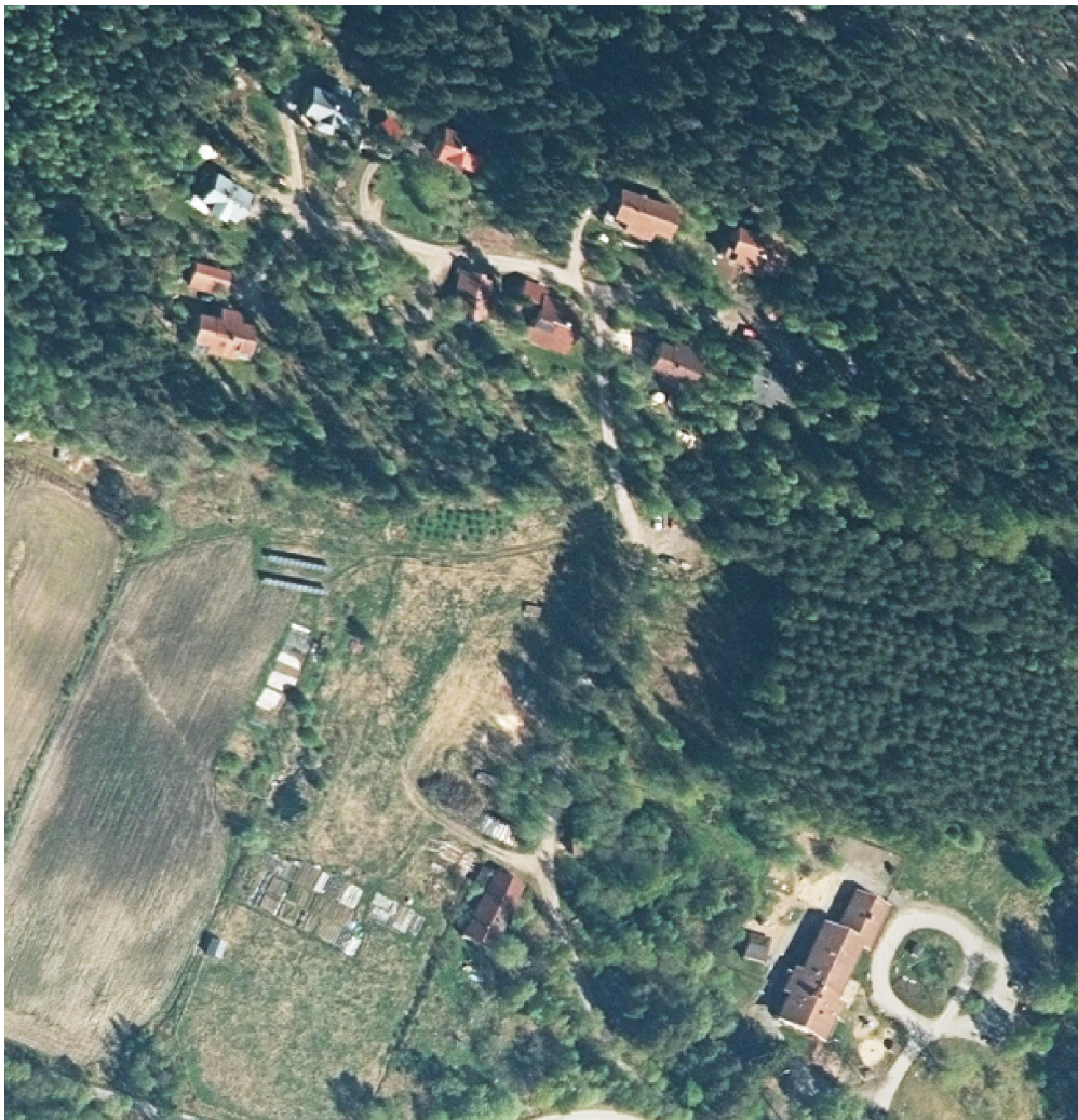
Kuva 3. Ortokuva Kangasalan Yhteiskylästä ja sen ympäristöstä. Oikean alakulman rakennus on päiväkotia, vasemmalla kylän tonttiin kuuluvaa peltoaluetta viljelypalstoinen ja aurinkopaneeliseinen. Itse kylä raitteineen on kuvassa keskellä yläreunassa metsän ja pellon rajalla. Kuva: Maanmittauslaitoksen ortokuvatietokannan 02/2019 pohjalta muokannut Adele Halttunen.
