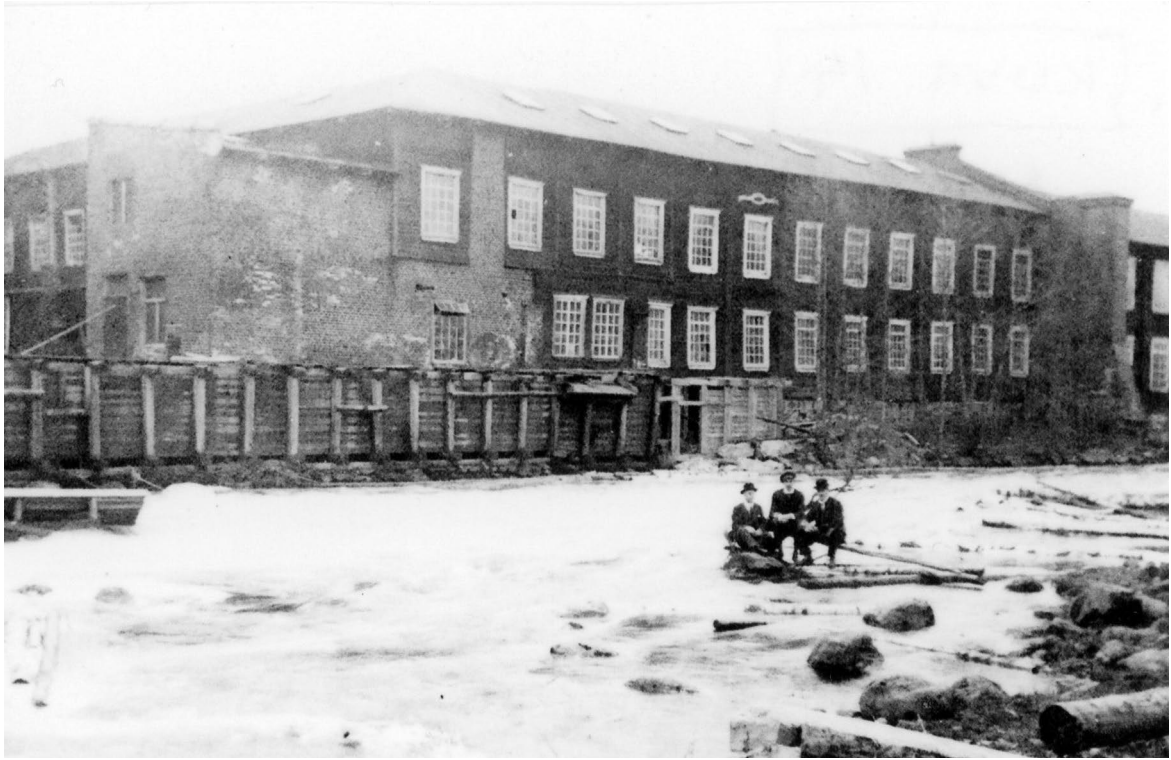
Kuva 14. Kaasmarkun verkatehtaan alla kulki kanava, johon vesi virtasi joesta vasemmalla näkyvää ränniä pitkin. Kesällä 1915 K. W. Huhtala urakoi kanavan syventämisen. Ulvilan kotiseutu yhdistyksen kokoelmat.
