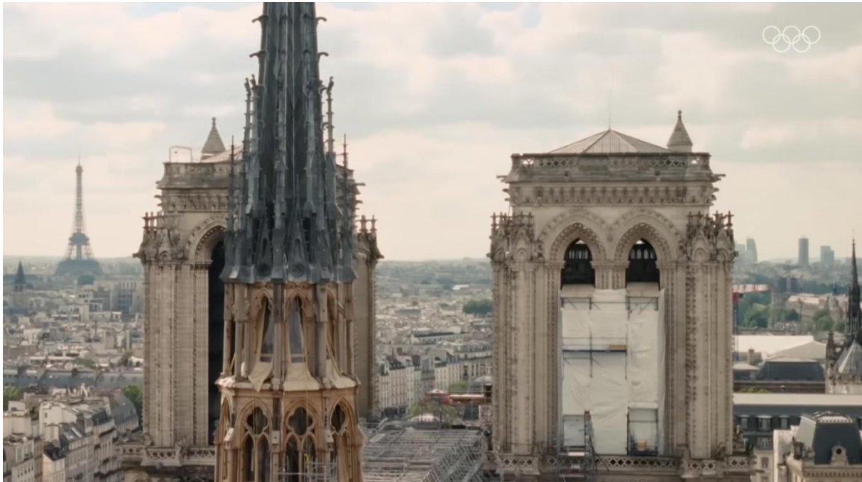
Kuva 7. Kuvakaappaus avajaislähetyksestä. Notre-Dame avajaisissa rakennustelineineen. Keskellä kunnostettu keskustorni, joka on järjestyksessään jo kolmas (vrt. kansikuva). Eiffel-torni hämmöttää taustalla.
