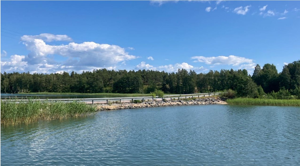
Kuva 8. Sommarösundin silta Paraisilla. Ajosuunnassa pohjoisesta etelään "sillan" ensimmäinen puolikas (kuvassa) on todellisuudessa täysin umpinainen pengeri. Sillan keskellä on pieni hiekkasärkkä tai saari, jonka ympäristö on ruovikoitunut. Heti saaren jälkeen pengertiessä on silta, jonka kannen pituus on 4,6 m ja virtausaukko halkaisijaltaan noin 4 m. Pengertien ensimmäinen puolisko estää siis veden virtauksen täysin, mutta sen toisella puoliskolla läpivirtaus on mahdollista. Siitä huolimatta pengertie rajoittaa kokonaisuudessaan veden vapaata liikettä merkittävästi, sillä ilman sitä salmen läpi virtaisi huomattavasti enemmän vettä. Kuva: Vilhelmiina Virtanen 9.7.2025.
