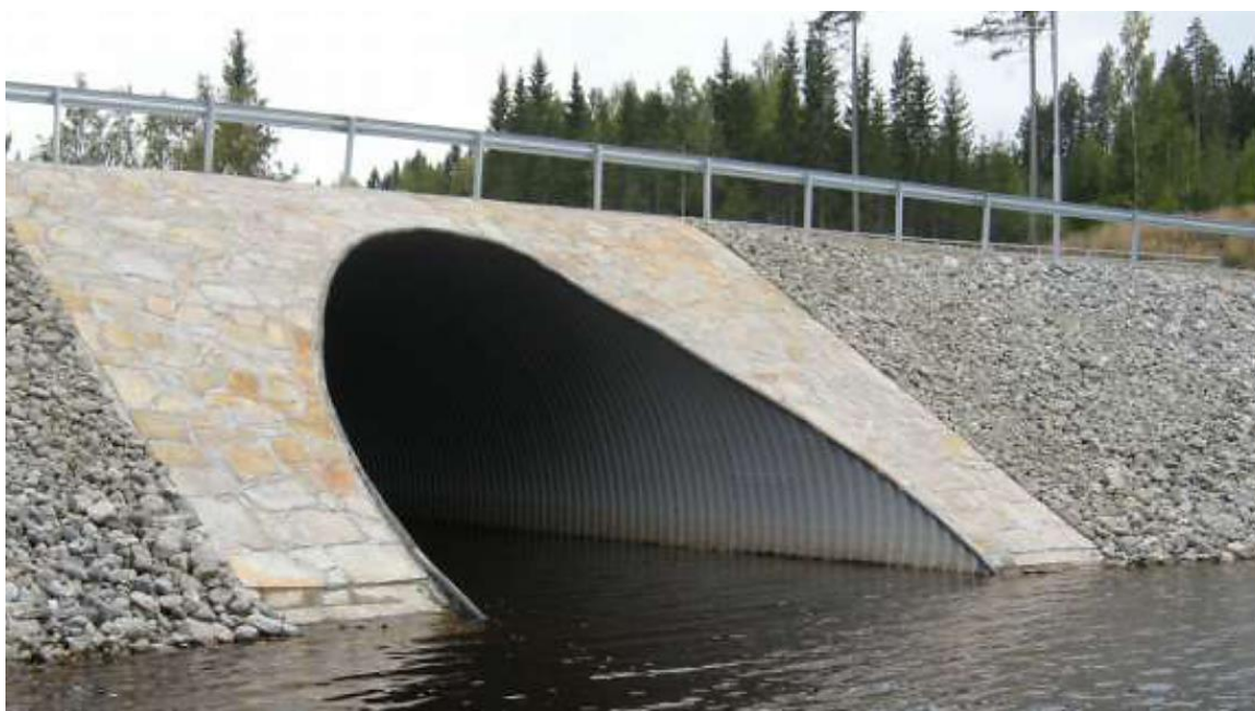
Kuva 6. Aallotetusta teräsputkesta tehty putkisilta tiepenkereessä. Kuva: Ekholm 2020.
