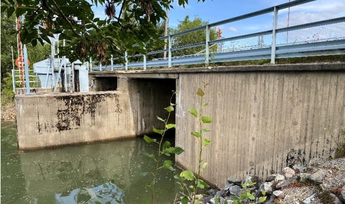
Kuva 24. Marikarin silta Paraisilla. Silta toimii säännöstelypatona ja venesulkuna. Kuva: Siltatyöt Varsinais-Suomessa vuonna 2025 (2025).
