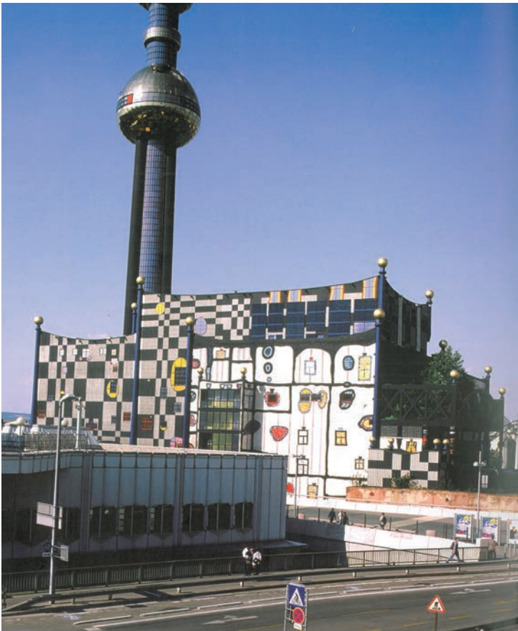
Spittelaun voimalaitos 2005. Fernwärme Wien GmbH
