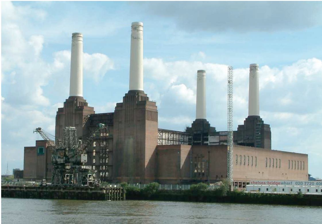
Battersean voimalaitos Lontoossa 2010. Guichard, Aurelien, Wikipedia
