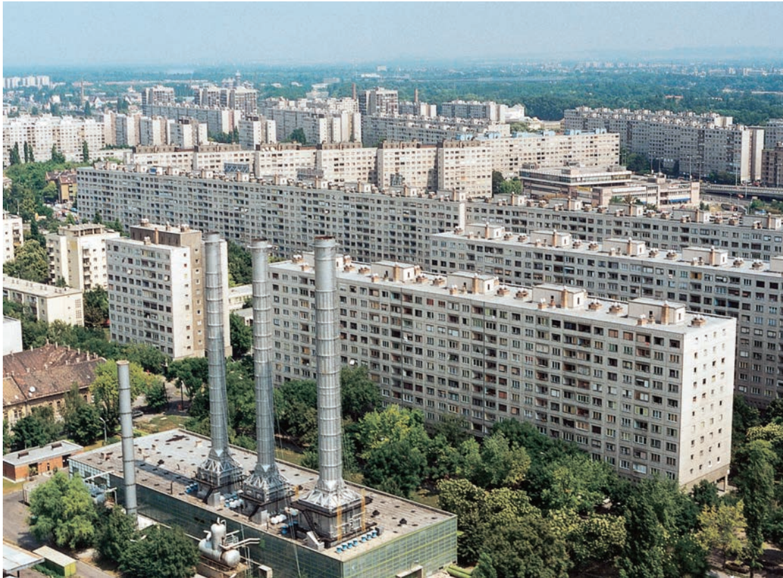
San Marcon kaukolämpölaitos Budapestin esikaupungissa 2005. Főtáv Zrt
