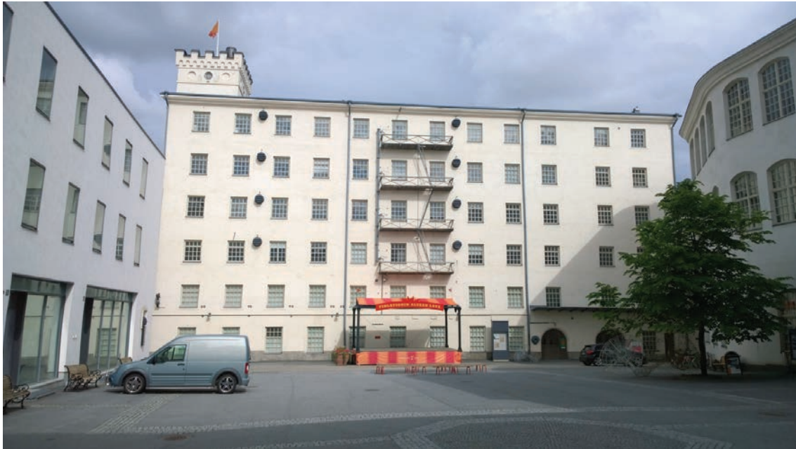
Tampereella Tammerkosken rannalla sijaitseva 1836–1837 rakennettu Kuusvooninkinen tänä päivänä. Vuojala, Petri
