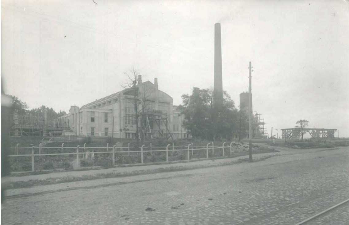
Suvilahden voimalaitoksen laajennus lopulliseen muotoonsa vuonna 1913. Toinen savupiippu nousemassa. Helen Oy
