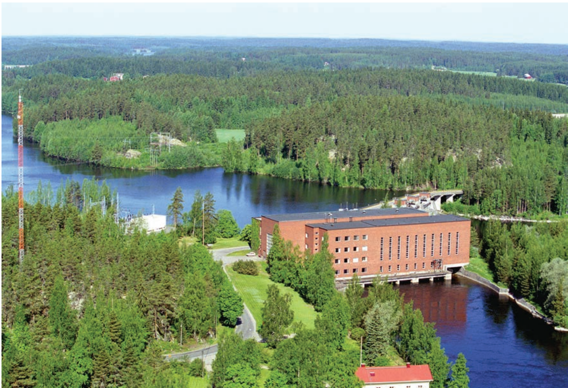
Mankalan vesivoimalaitos Kymijoessa. Helen Oy
