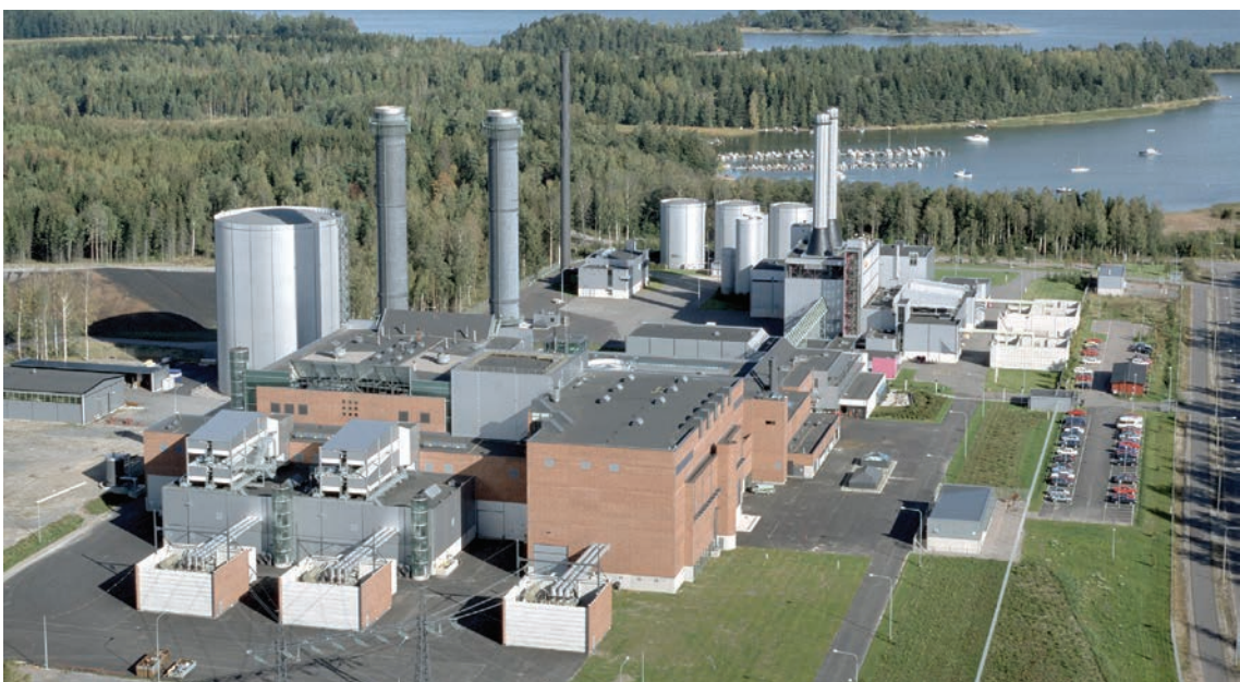
Ilmakuva Vuosaaren voimalaitoksesta lopullisessa asussaan ennen Helsingin suursataman rakentamista 1990-luvulla. Helen Oy
