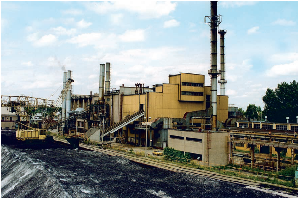
Pruszkowin voimalaitos Varsovan lounaispuolella 2005. Polish District Heating Association
