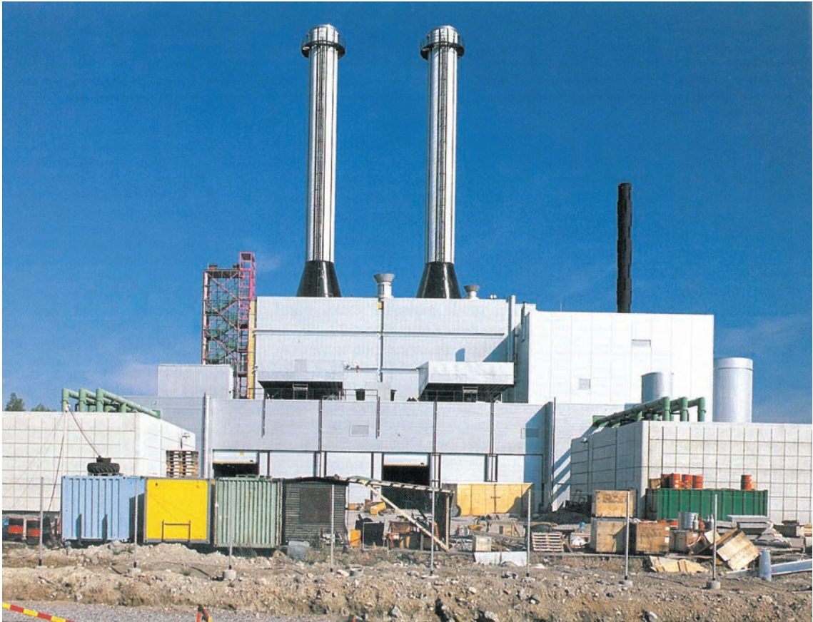
Vuosaaren A-voimalaitos rakenteilla vuonna 1990. Helen Oy
