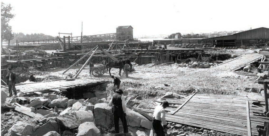
Suvilahden voimalaitoksen perustuksia kaivetaan vuonna 1908. Brander, Signe. Helsingin kaupunginmuseon kokoelmat
