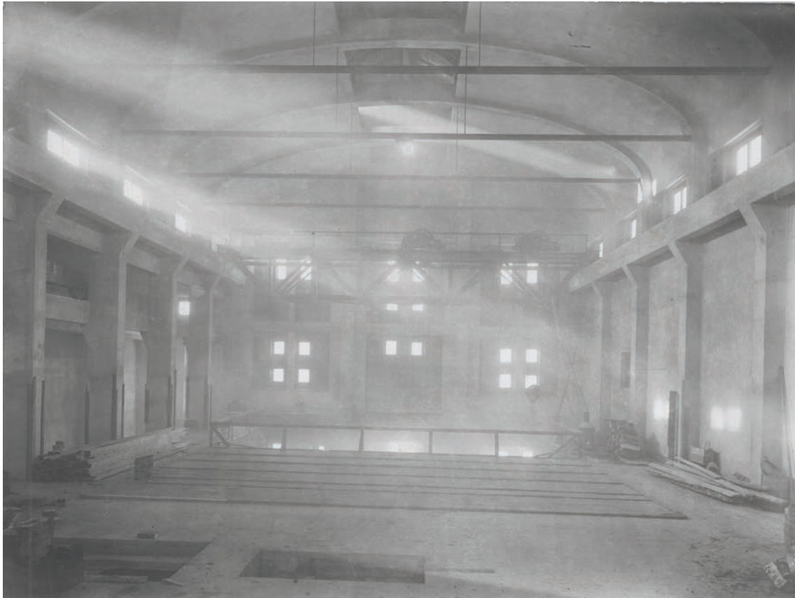
Suvilahden voimalaitoksen turbiinihalli betonivalutöiden valmistuttua. Helen Oy
