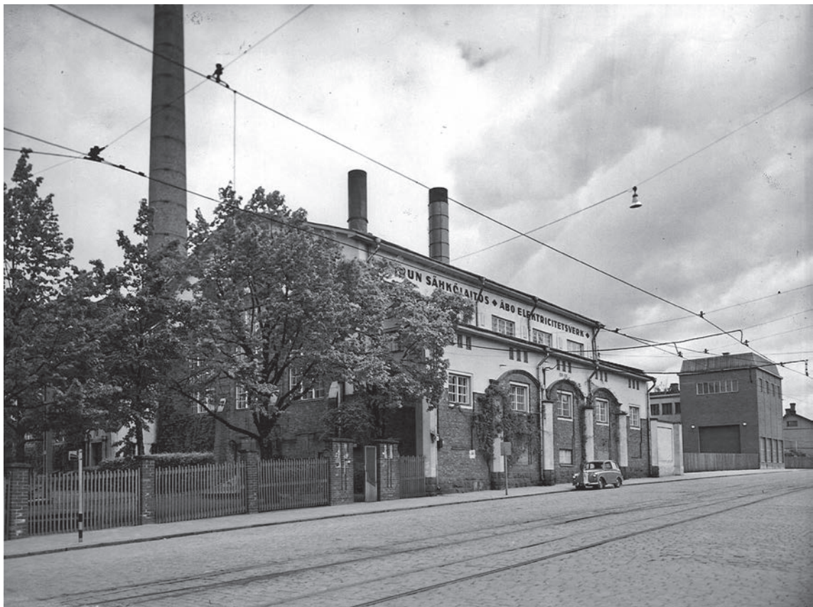
Turun Linnankadun voimalaitos 1950-luvulla. Julkisivu etelään. Turku Energia Oy
