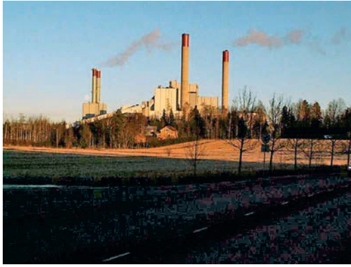
Vantaan Martinlaakson voimalaitos lännestä. Vantaan Energia Oy
