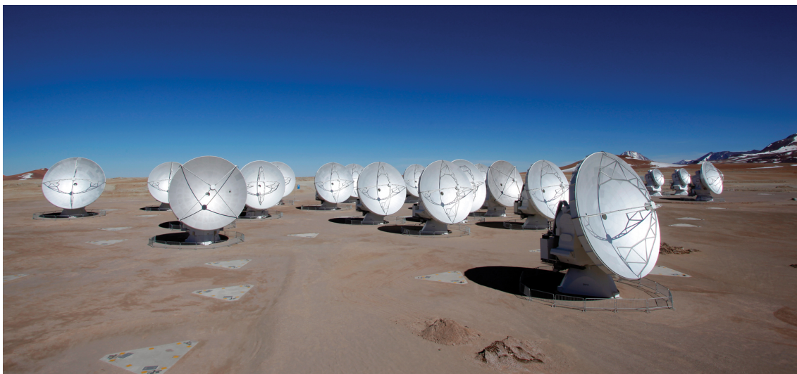
Kuva 2. ALMA -teleskooppiryhmä, joka koostuu 66:sta radioteleskoopista ja sijaitsee Pohjois-Chilessä, Atacaman aavikolla. Teleskoopit ovat aseteltu tarkasti tietyille paikoille, jotta radiointerferometriaa voidaan käyttää. Jokainen paraboloidipeili kerää radiosäteilyä, ja interferometriavun avulla niiden signaalit voidaan yhdistää yhdeksi suureksi kuvaksi. [24]
