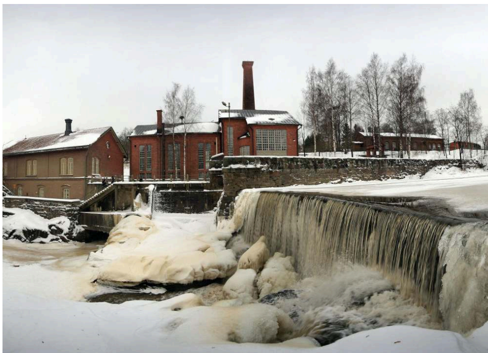
Fig. 4. – Cascade et ancienne centrale hydroélectrique au musée de la Technologie d’Helsinki.
