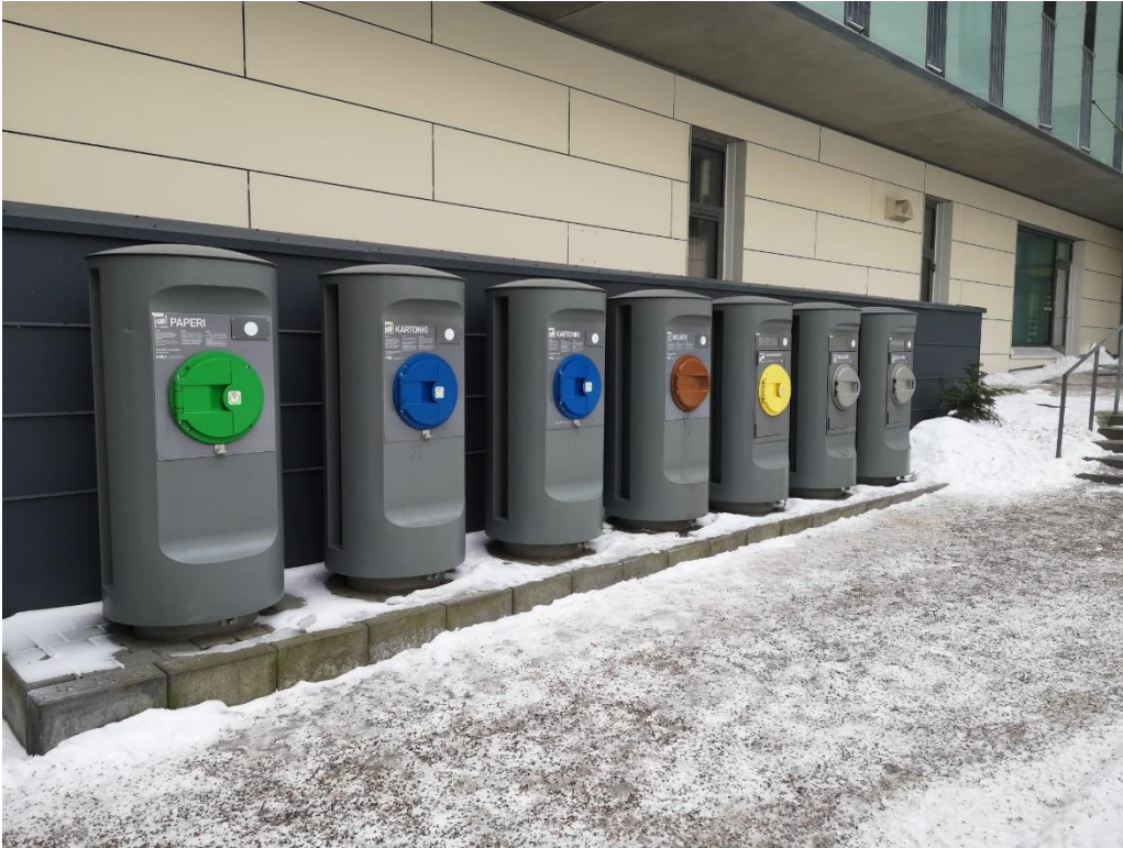
Kuva 7. Jätkäsaassa jätteen keräys perustuu maan alla toimivaan putkikuljetusjärjestelmään. Jätteet kulkevat putkistoissa keräyspisteiltä (kuvassa) keräysasemalle noin 70 km tuntinopeudella. Kuva: Elina Poukka
