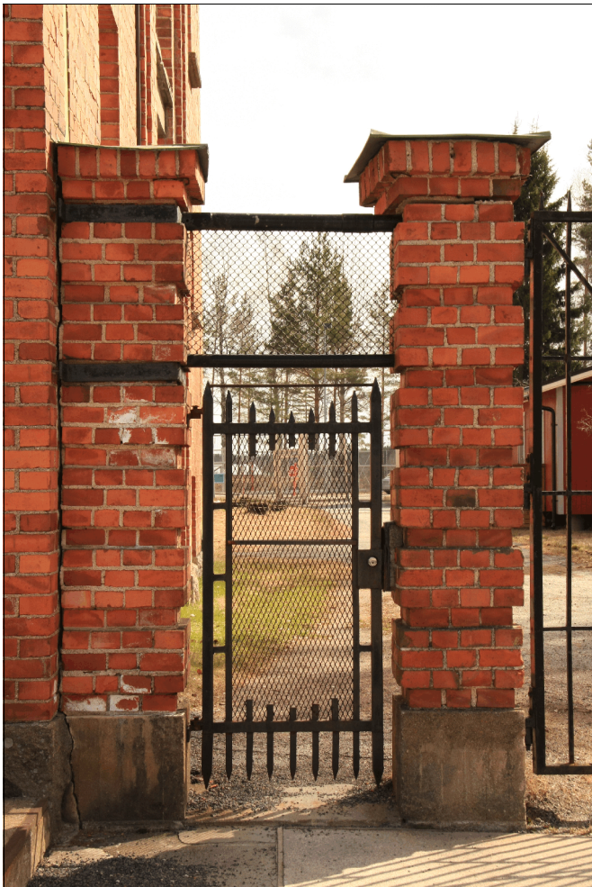
Portti vankilan sisäpihalle.
