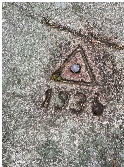
Kuva 2. Kolmiomittauksen kiintopiste Järvenpään Saunakallion Vihtakadun koulun läheltä olevan kallion päältä. Kuva: Antti Järvenpää
