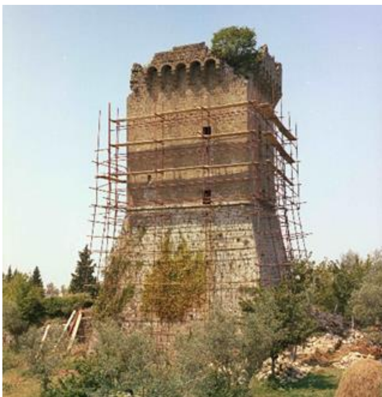
Fig. 14. La Torre all'inizio dei lavori.
