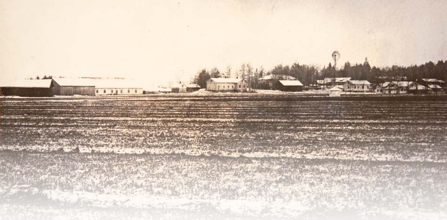
Aittamäen kartanon peltoa ja talousrakennuksia 1900-luvun alussa. Vasemmalla savesta rakennettu navetta ja kuvan keskellä työvään asuinrakennus. Kuva: Pelkolan kartanoarkisto.
