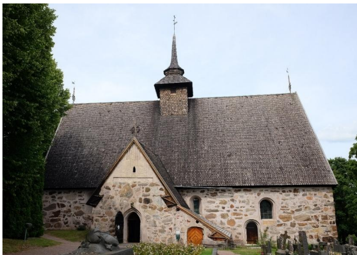
Kuva 8. Rymättylän keskiaikainen kivikirkko. Katon päällä keskellä on tornimainen kattoratsastaja. Etelämuurissa runkokuoneesta ulkoneva harjakattoinen asehuone. Kuvattu pohjoiseen. Kuva: Saara Ruohonen.
