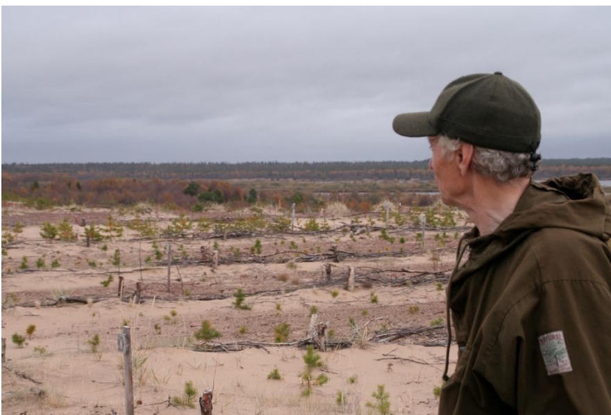
Kuva 15. Leri Kazagovin työmaa, männyn taimet on istutettuna ja suojattuna eroosiolta.
