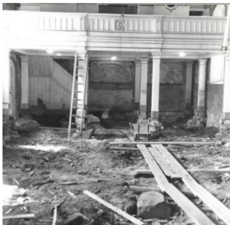
Kuva 13: Raisen kirkon runkokuoneen kaivaus. Kuva: Tapio 1969, kuvatunnus tutkimusraportissa 94647: 14.
