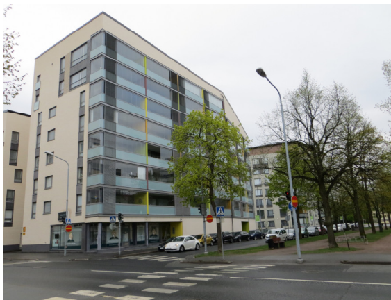
Kuva 21. YIT:n rakentama asuinkerrostalo Länsipuiston ja Mikonkadun kulmassa. (Kuva Mika Koski, 14.5.2016)
