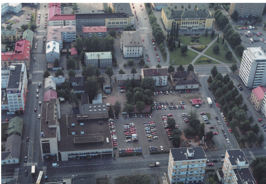
Kuva 2. Karhupään kaupunginosan korttelin 44 ilmakuva. Kuvattu pohjoisesta etelään. Korttelia rajaavat kuvan oikeassa reunassa Eteläpuisto, ylhäällä Itsenäisyydenkatu, vasemmalla Antinkatu ja alhaalla Mikonkatu. (PKSA)
