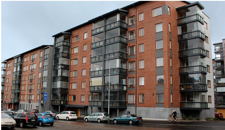
Kuva 33. TOAS:n Jarinsampo Sammonkadun puolelta. (Kuva NCC)
