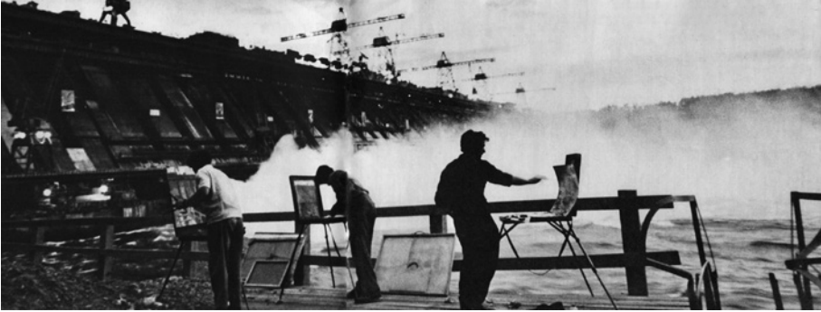
Kuva 1. Moskovalaiset taidemaalarit työn tiimellyksessä Bratskin voimalaitostyömaalla. Lähde: NL 82/1963, 20.
