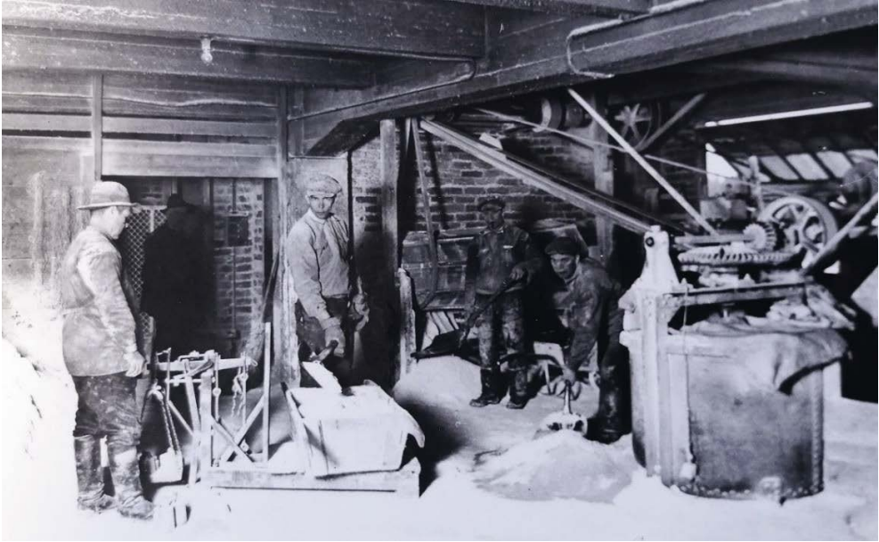
Kuva 3: Fourcault-vetokoneesta huolimatta lasinvalmistus vaati paljon manuaalista panosta ennen vetovaihetta sekä sen jälkeen. Kuva on lasimassan raaka-aineiden punnituksesta vuodelta 1932, kuvaajana Matti Mannelin. Kuva: LHM/LLk.
