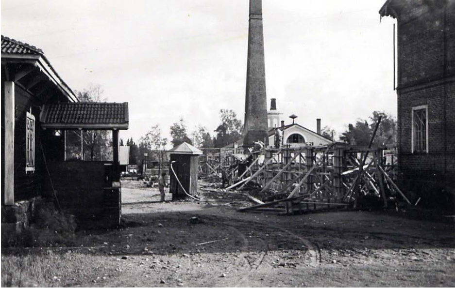
Kuva 39: Rakennustyötä Nuutajärvellä syyskuussa 1950. Kuva: https://urjala.kuvat.fi /Edvard Holmbergin kokoelma.
