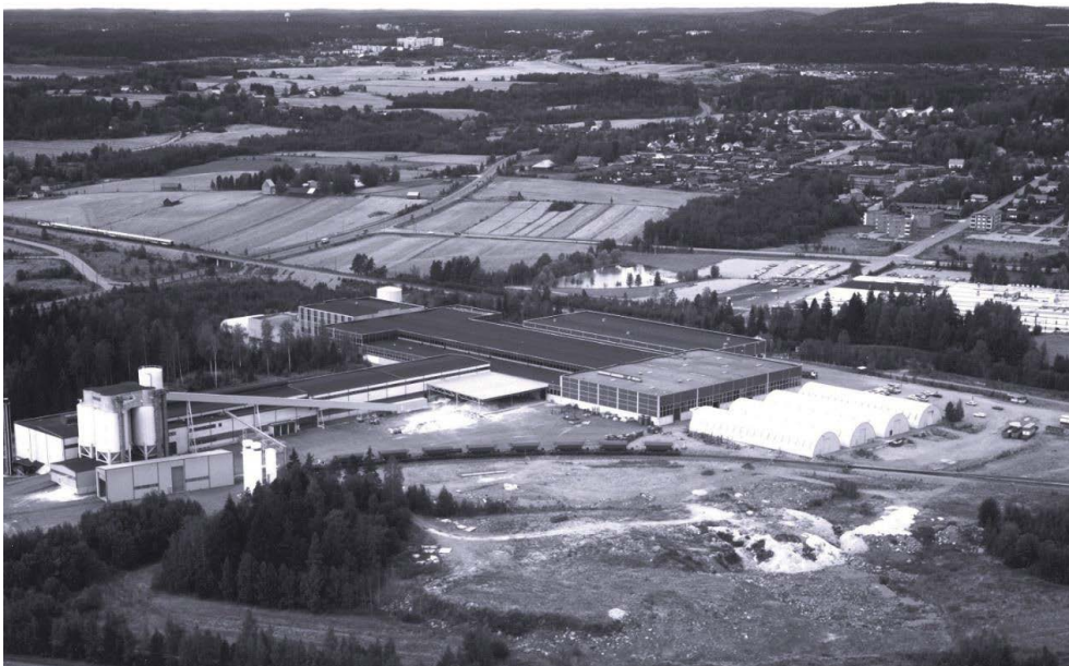
Kuva 15: Laajennetuissa tehdastiloissa aloitti työn noin 230 lasialan osaajaa tai vähintäänkin nopeaa oppijaa. Float-lasin valmistus tehtiin uudisosassa vasemmalla ja aikaisemmat tehdasneliöt muuntuivat suureksi leikkaus- ja jälkikäsitelytilaksi. Kuva: LHM/LLK.
