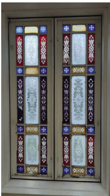
Kuva 50: Puukonttorin verholasi-ikkuna kuvattuna sisäpuolelta kunnostusprojektin aikana. Verholasi on puhallettua lasia, joka on tehty kaksikerroksisena. Kuviot tuodaan esiin hiomalla tai kaivertamalla ne tummemman lasikerroksen läpi. Nuutajärvellä säilynyt taidonnäyte on Gernheimin tehtaalla hallittua erikoisosaamista. Kuva: Minna Huuhka.
