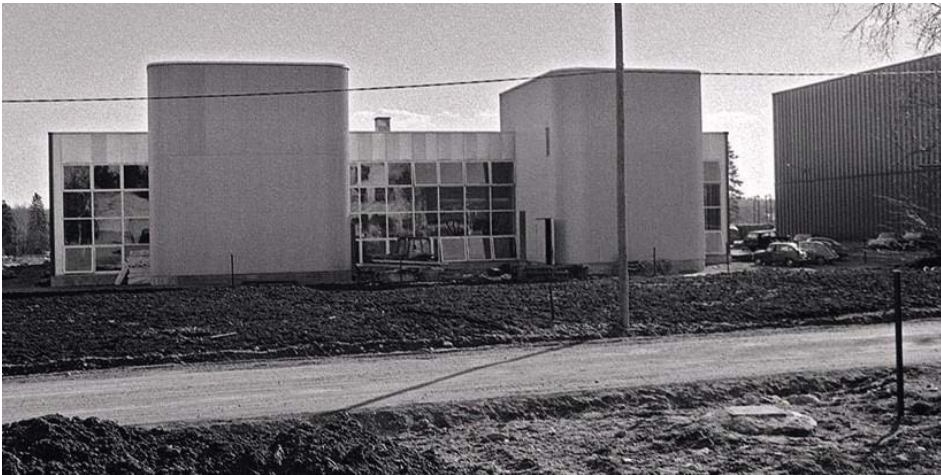
Kuva 42: Arkkitehti Markku Annilan suunnittelema Hakahytti valmistui syksyllä 1974 Pruukinraitin varrelle vastapäätä vanhaa tehdaskylää. Uuden mänkihallin kulma näkyy oikealla. Kuvaaja Jouni Saaristo. Kuva: https://urjala.kuvat.fi .
