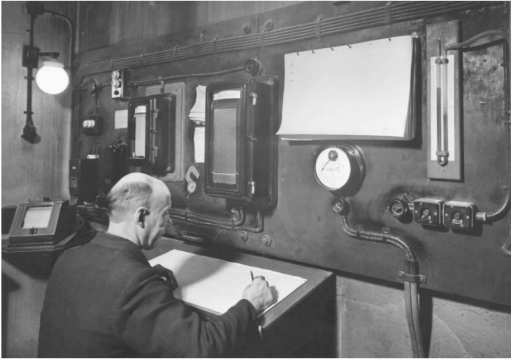
Kuva 6: Lahden tehtaan valvomossa pystyttiin 1945 seuraamaan tuotannon perusasioista uunipaineita ja lämpöä. Kuvassa lasinpuhaltaja Ivar Samuelsson uudessa työroolissa. Kuva: LHM/LLk.
