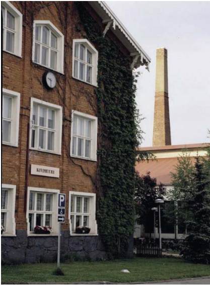
Kuva 47: Kivimuurin päätyfasadi oli ensimmäinen muutoksen kohteeksi joutunut alkuperäisrakenne. Ravintolan koristeellisin puuleikkauksin varusteltu terassi purettiin 1878 ja Costianderin suku teki ravintolatilasta tehdaskylän koulun. Sen siirtyessä myöhemmin omaan rakennukseen Kivimuurin tila jaettiin kahden kerroksen sijasta kolmeksi ja jälleen ulkoinen ilme muuttui. 337 Kuva: INDAVin kuva-arkisto.
