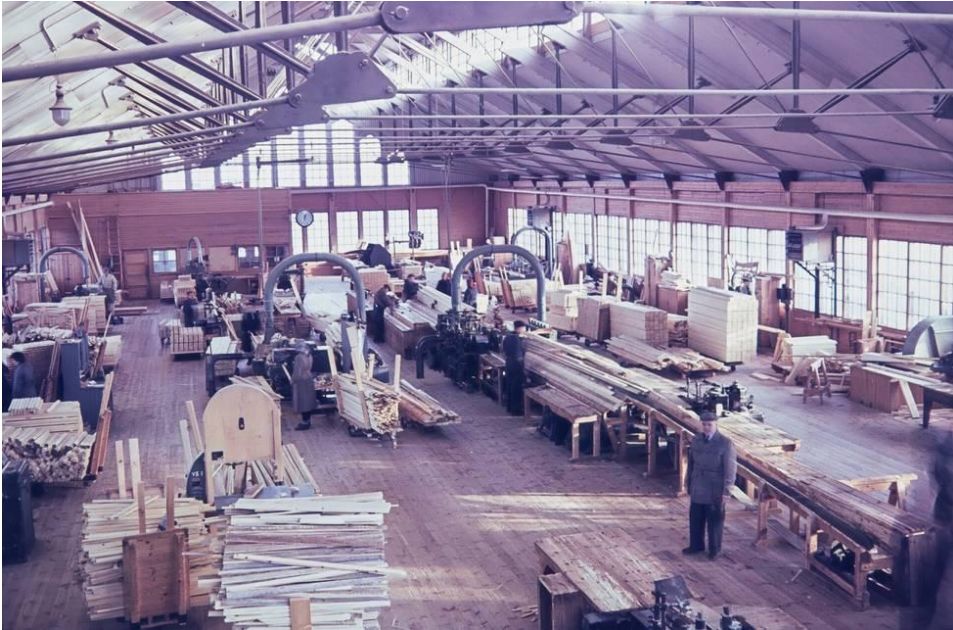
Kuva 5: ”Tämä harvinaislaatuinen kuva on otettu puutalotehtaaksi muutetun saharakennuksen sisällä vuonna 1955. Puutalotehtaan toiminta päättyi jo seuraavana vuonna.” 144
